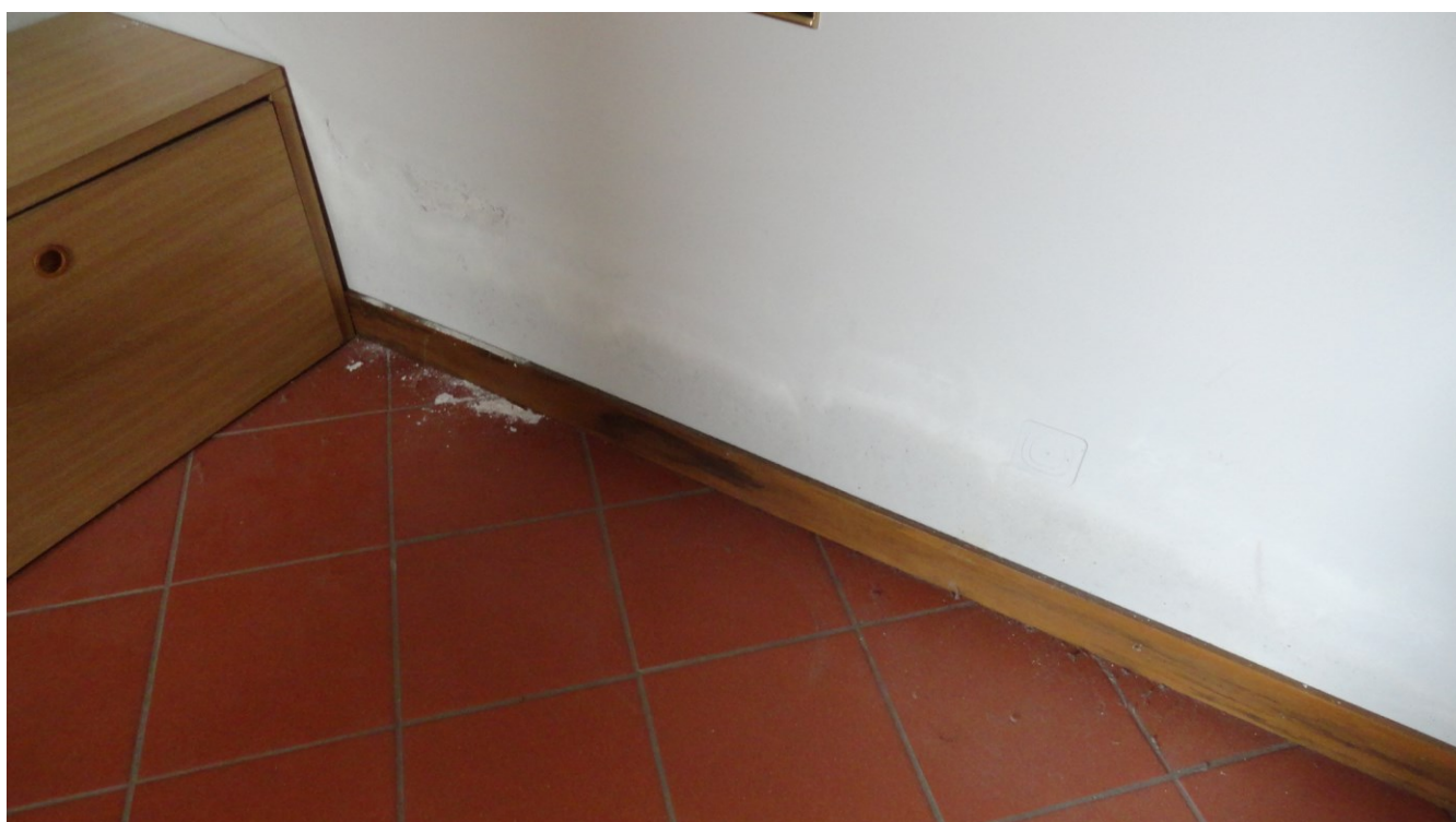
b) Muro perimetrale interno Camera Nord .ovest
