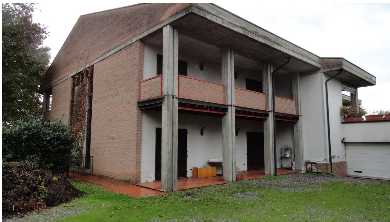
Fronte nord ovest : Piano Terra subalterno 2 ; Piano Primo subalterno 3 più autorimessa alla destra( subalterno 4 )
