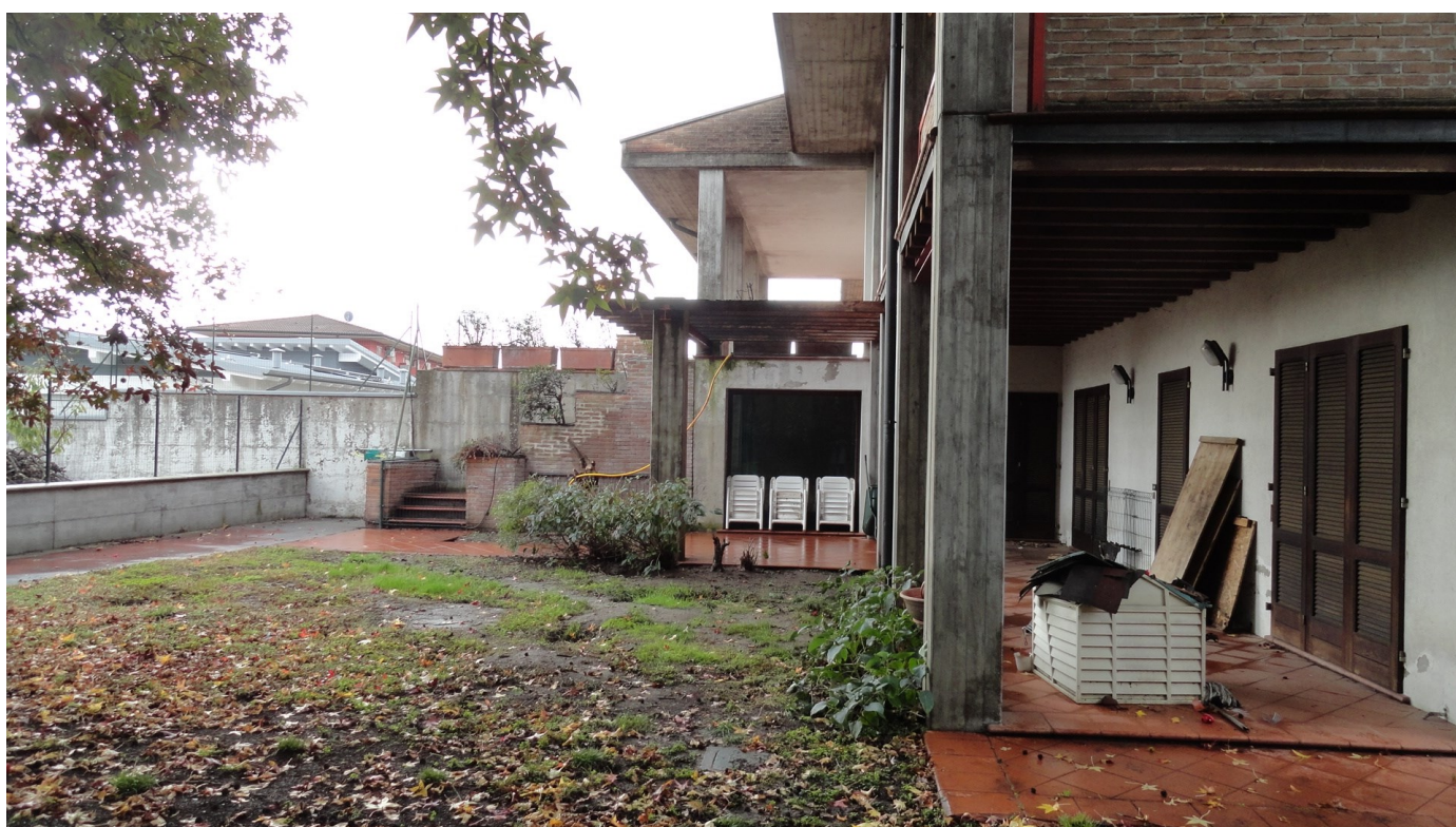
La corte interna a Nord Est: al Piano Terra il subalterno 2 ; al Piano Primo il subalterno 3
