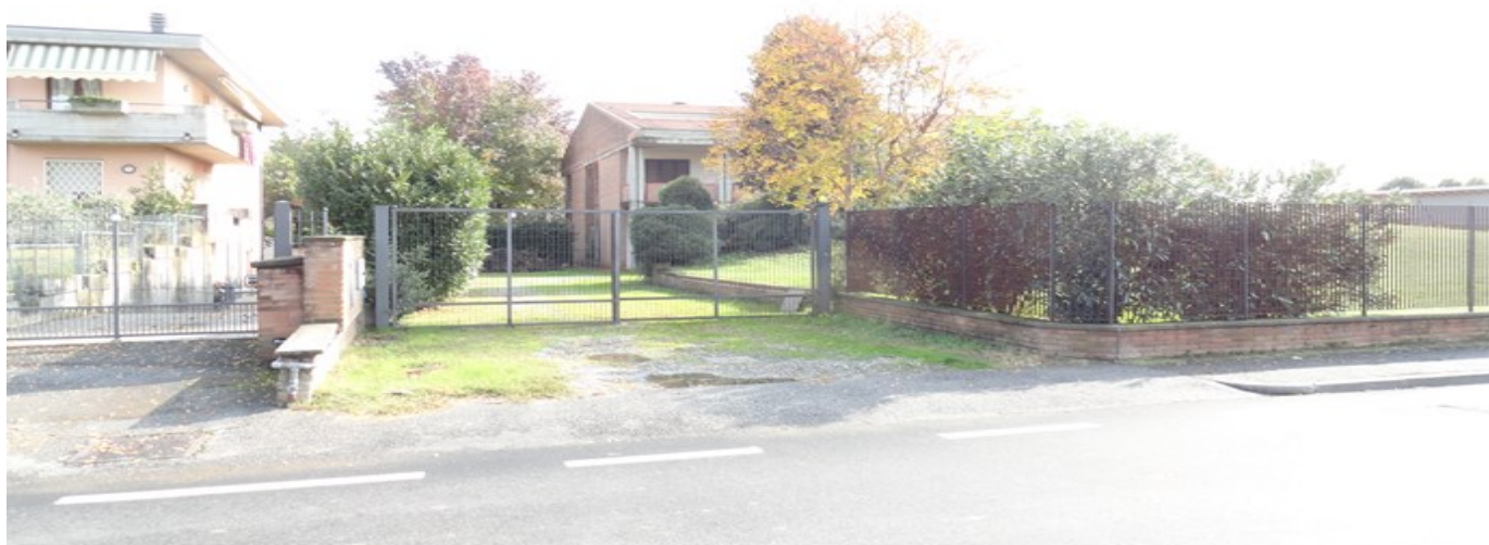
Ingresso Carraio , su Via Per Comezzano , estremo lato nord ovest del lotto
