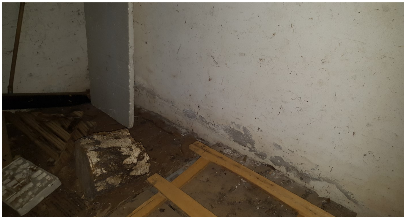
il locale ripostiglio all'interno della autorimessa
