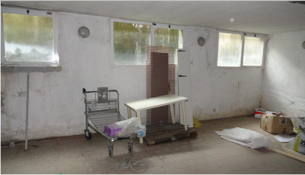
lato bocche di lupo
