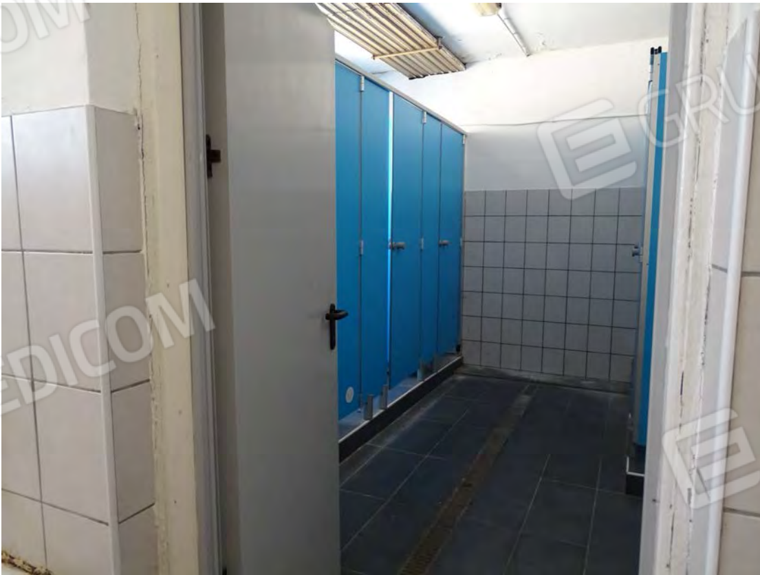
VISTA BAGNI PIANO PRIMO
