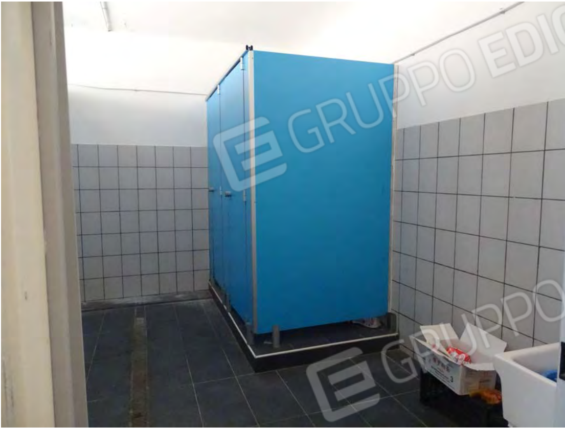
VISTA BAGNI PIANO PRIMO
