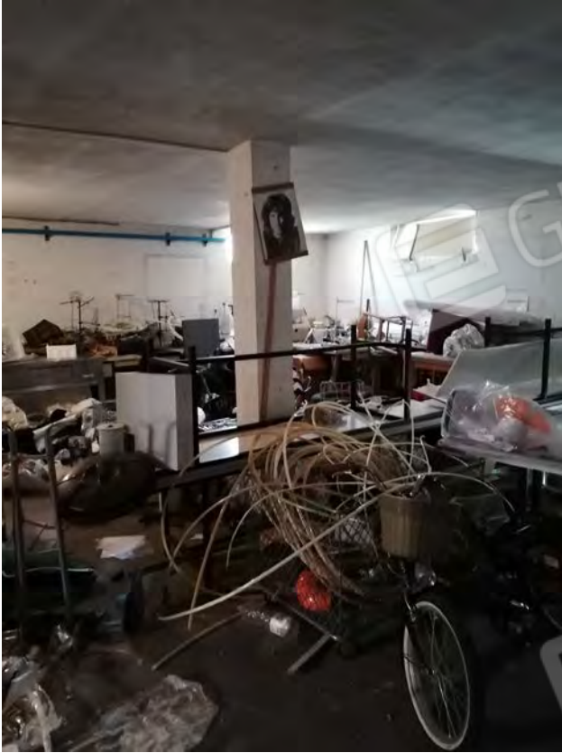
VISTA LOCALE CANTINA
