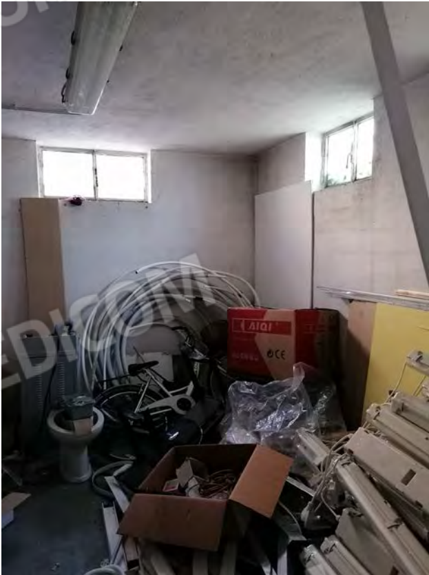
VISTA LOCALE CANTINA
