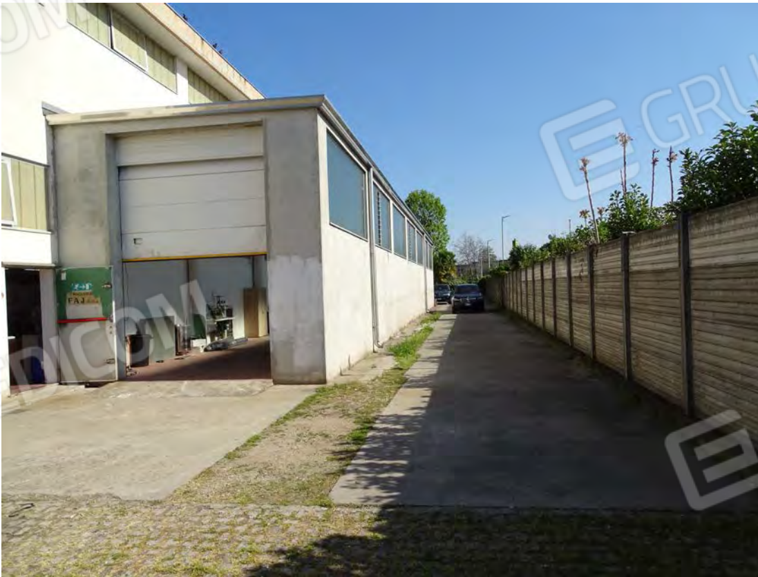
VISTA INTERNA CORTILE
