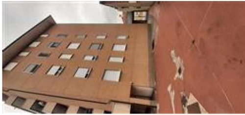
prospetto dal cortile interno
