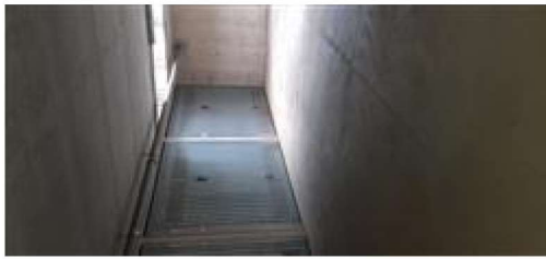
vista dal corsello di manovra
