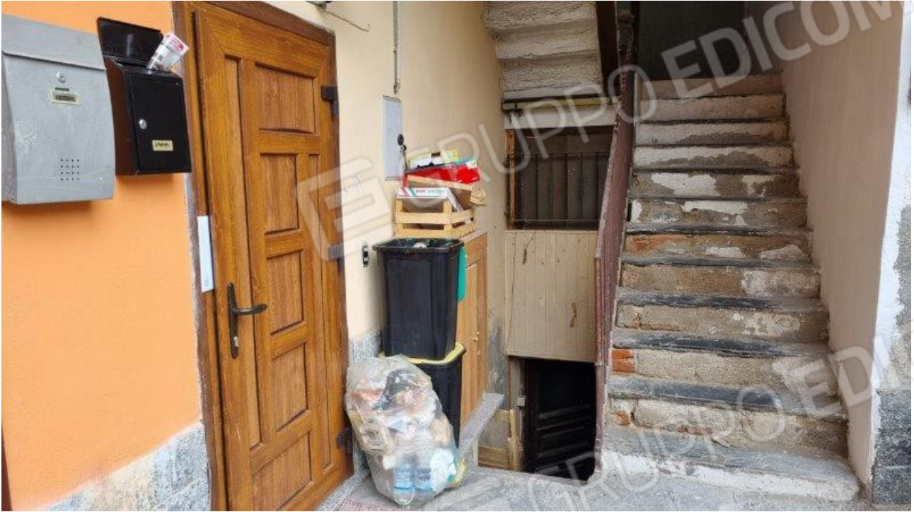
vista da cortile (scala chiusa accesso cantina)
