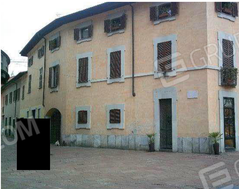
VISTA DA VIA CAVOUR
