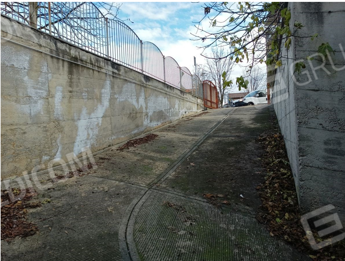
Scivolo del corsello carraio comune
