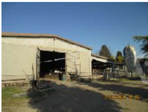
Foto 12- esterni immobile A4 Stalla
