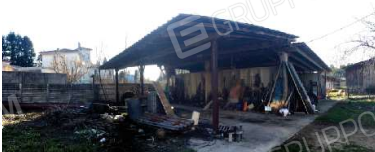
Foto 9- esterni immobile A2 tettoie-depositi
