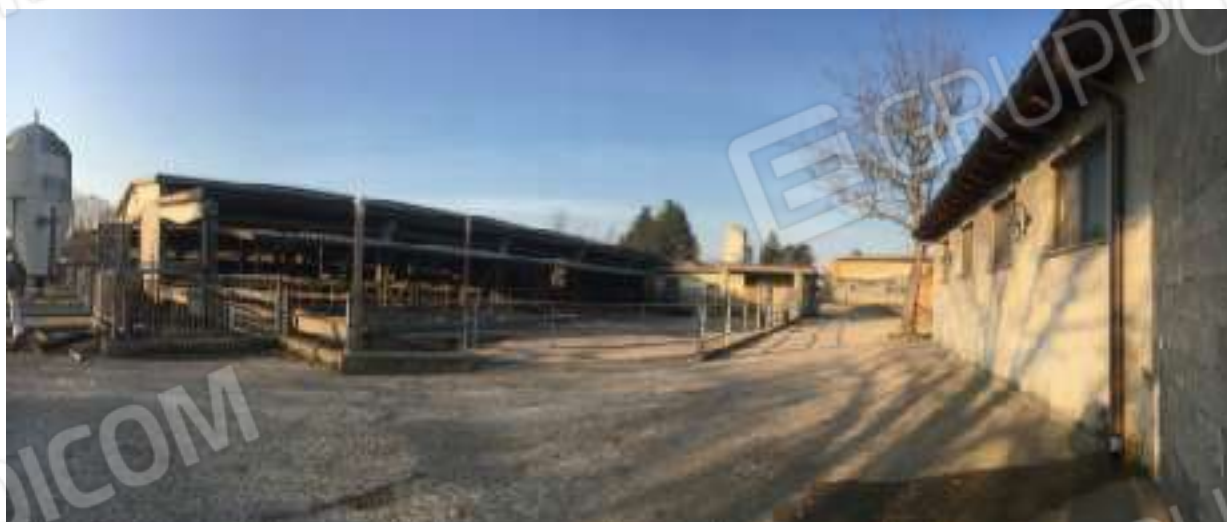
Foto 12- esterni immobile A4 Stalla area Paddock
