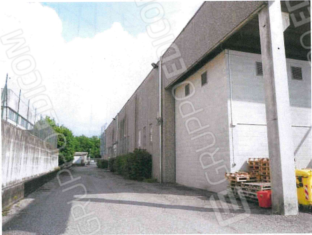
Foto 09 – Il prospetto Nord-Est
