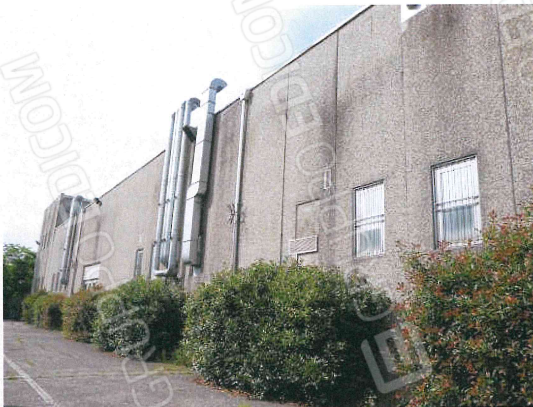
Foto 05 – Il prospetto Sud-Ovest
