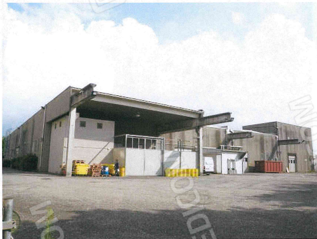
Foto 08 – Il prospetto Nord-Ovest
