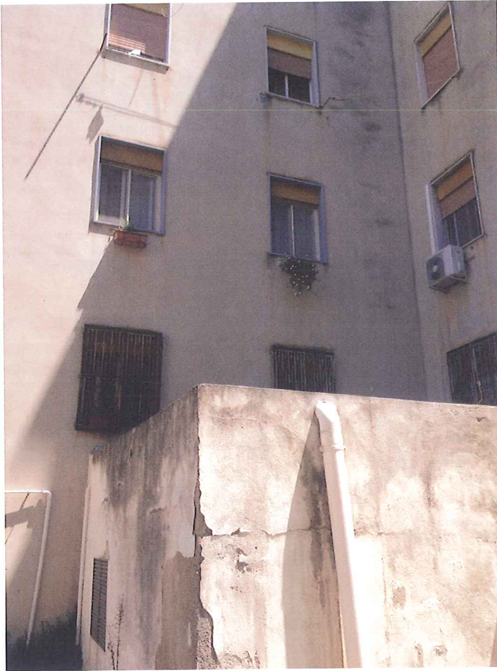
Pozzo (F): vano contenente il pozzo ed edificio limitrofo
