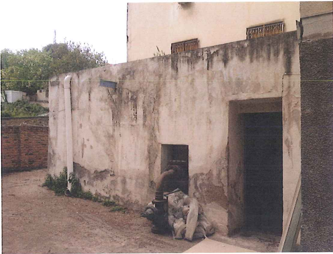
Pozzo (F): vano contenente il pozzo
