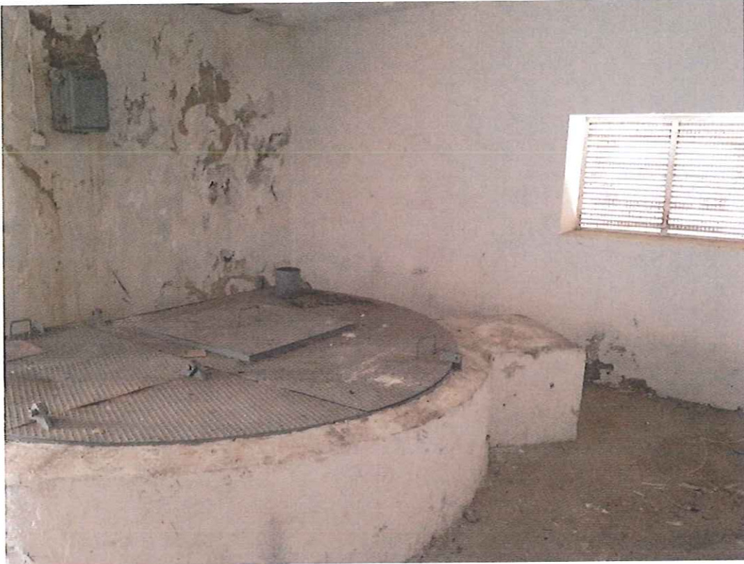
Pozzo (F): interno del vano
