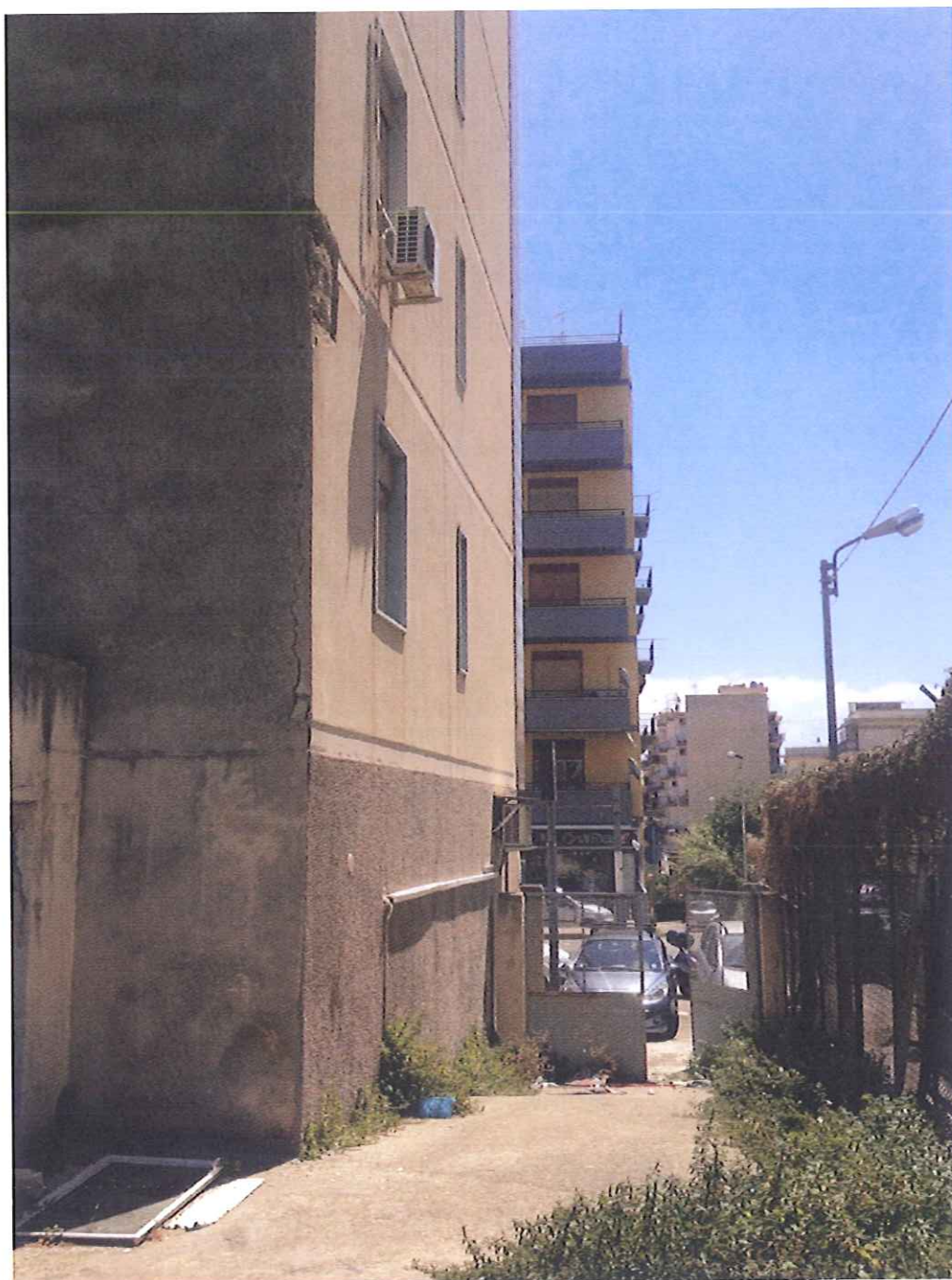
Pozzo (F): corte interna ed edificio limitrofo
