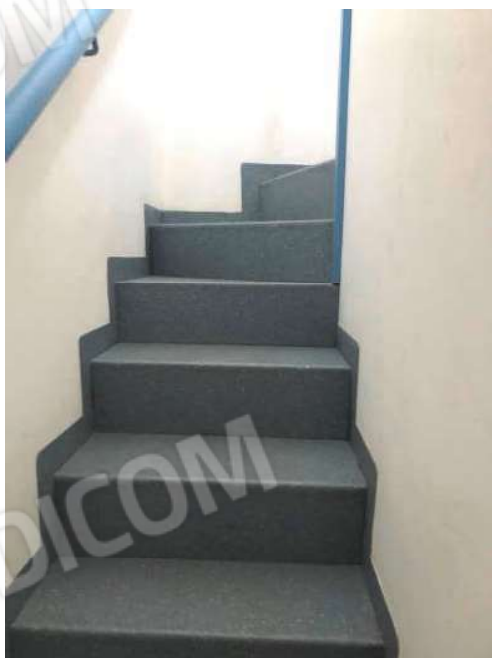
Foto 25 scala accesso lastrico solare
