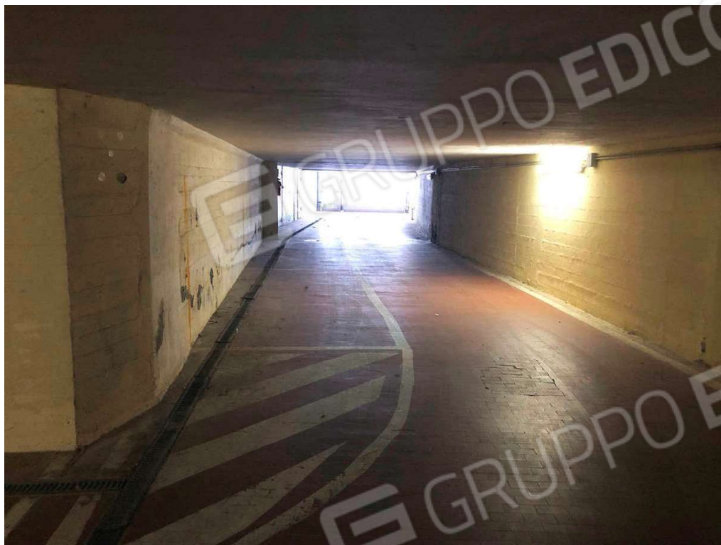
Foto 31 – corsello carraio piano interrato
