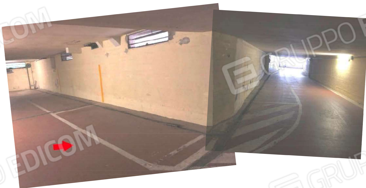
Foto 32- posto auto legato al Sub 11- foto 33 corsello carraio
