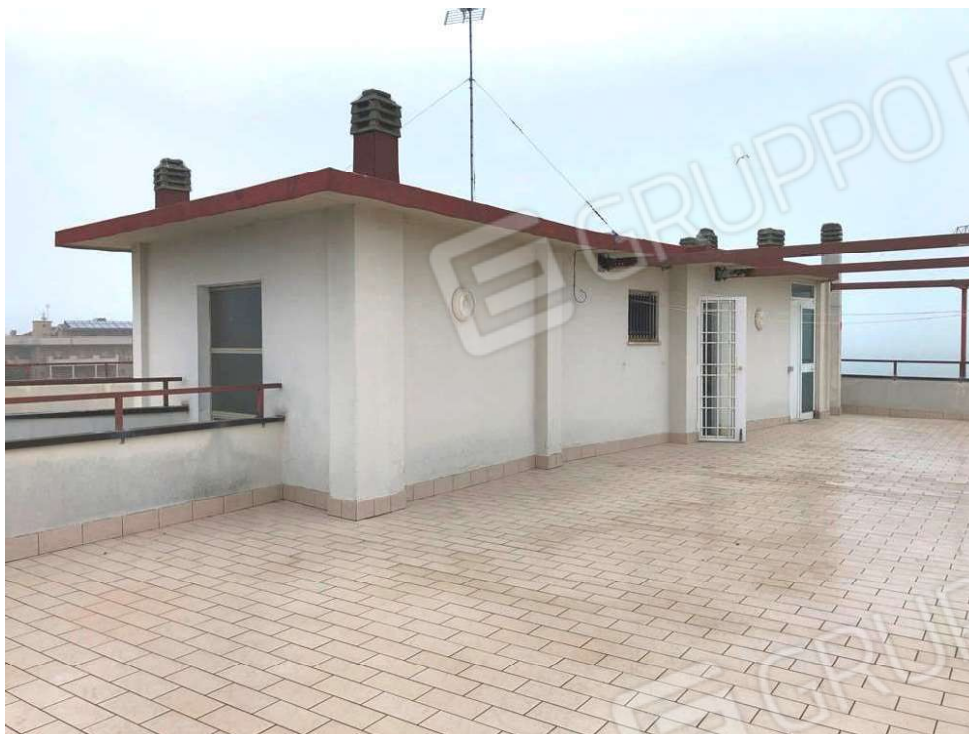
Foto 27 – lastrico solare – porta accesso scala interna
