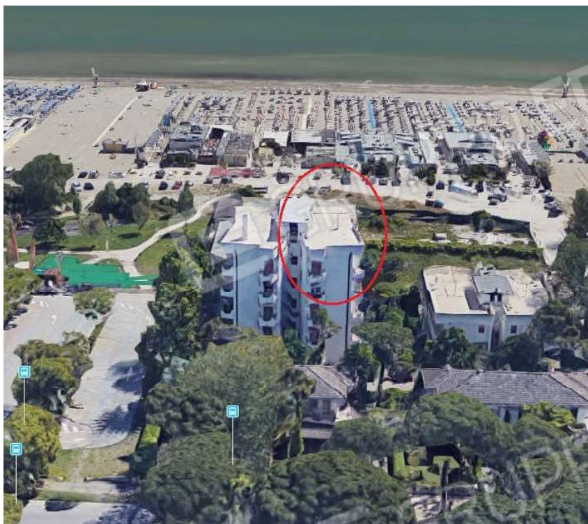
Foto 2 –Foto satellite – vista lato Ovest
