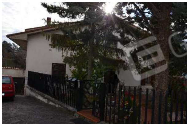
ESTERNO – FOTO N. 1 INGRESSO CON CORTE SUPERIORE
