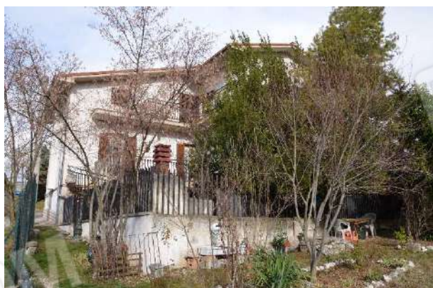
ESTERNO – FOTO N. 3
