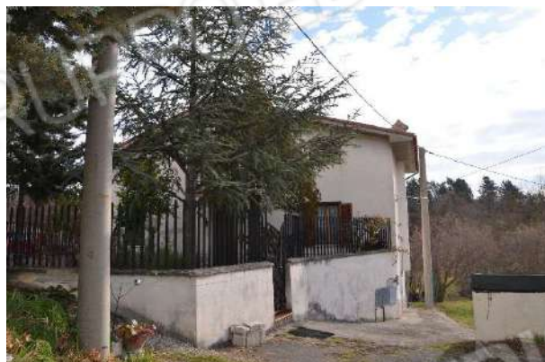
ESTERNO – FOTO N. 2
