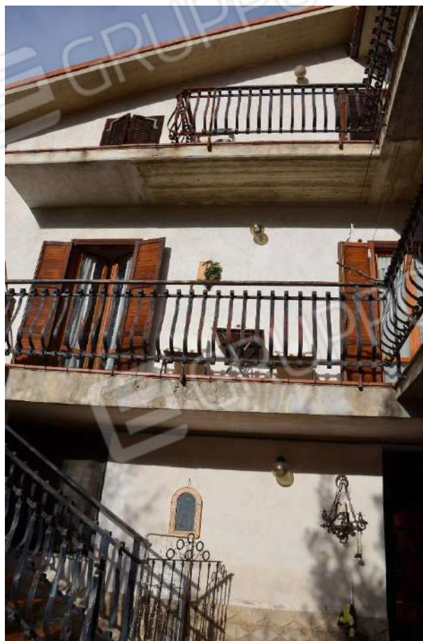
ESTERNO – FOTO N. 5
