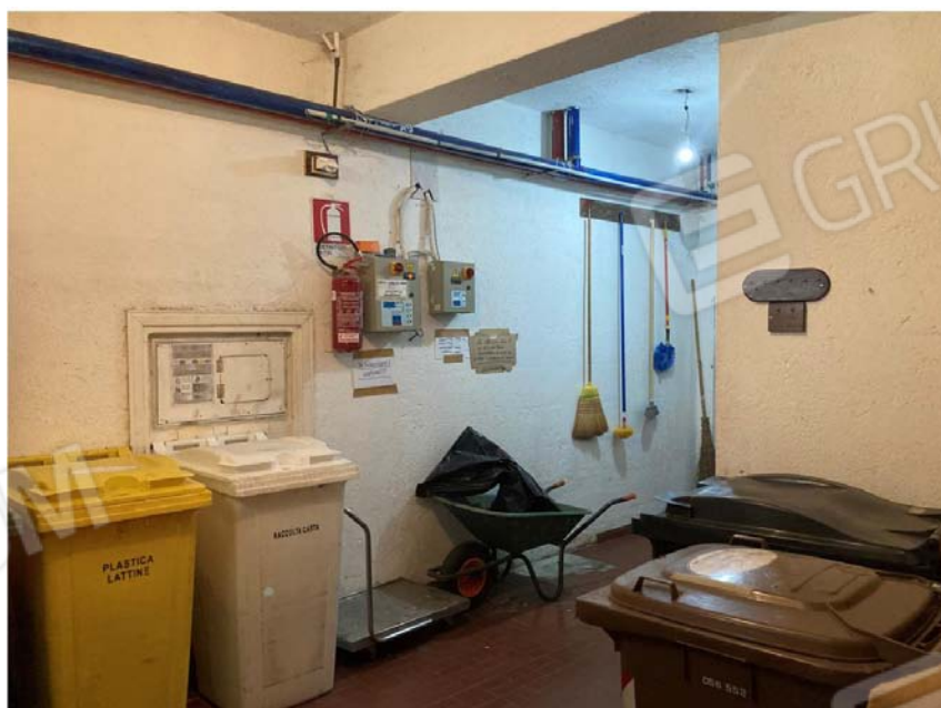
PIANO TERRA DISIMPEGNO
