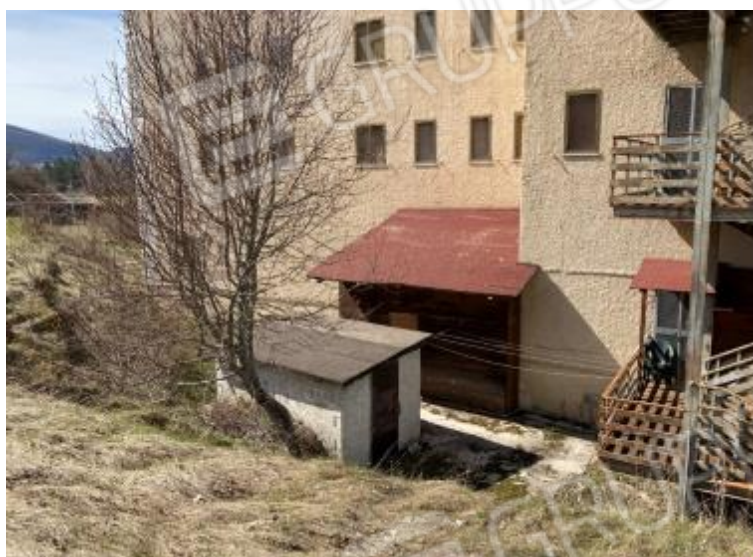
LOCALE NON ACCATASTATO LATO NORD EST
