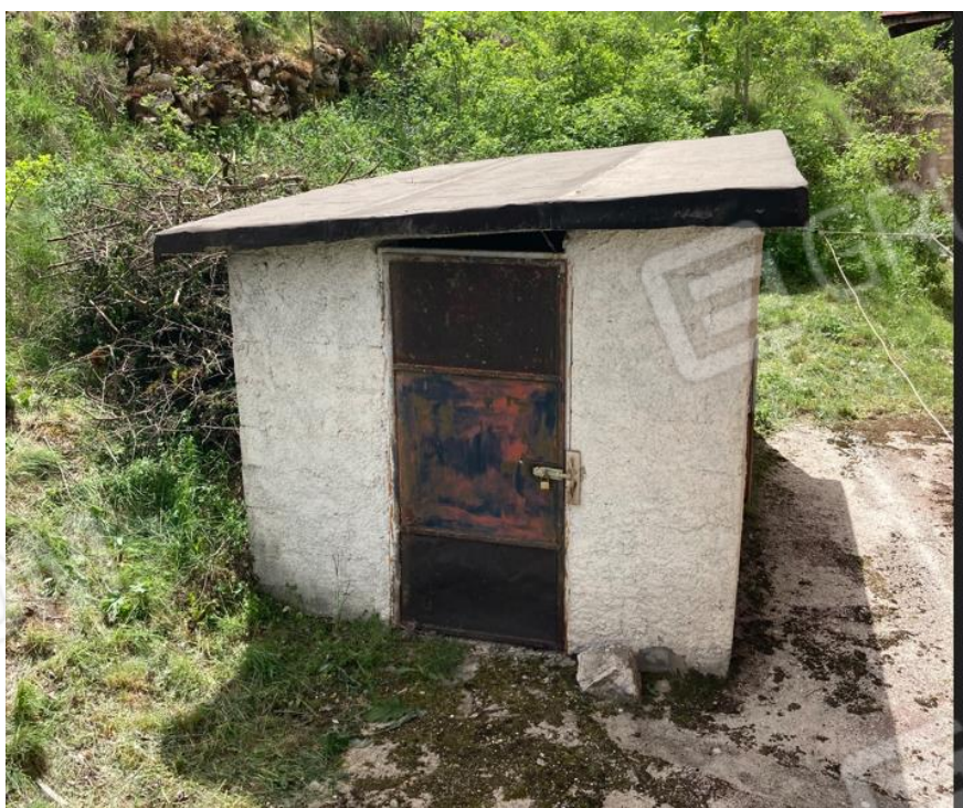
DEPOSITO ESTERNO LATO NORD EST
