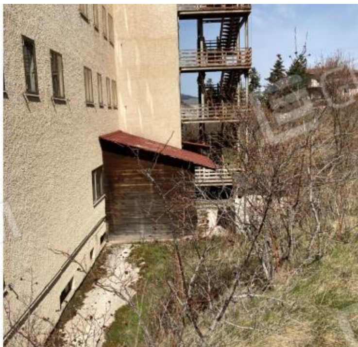
LOCALE NON ACCATASTATO LATO NORD EST
