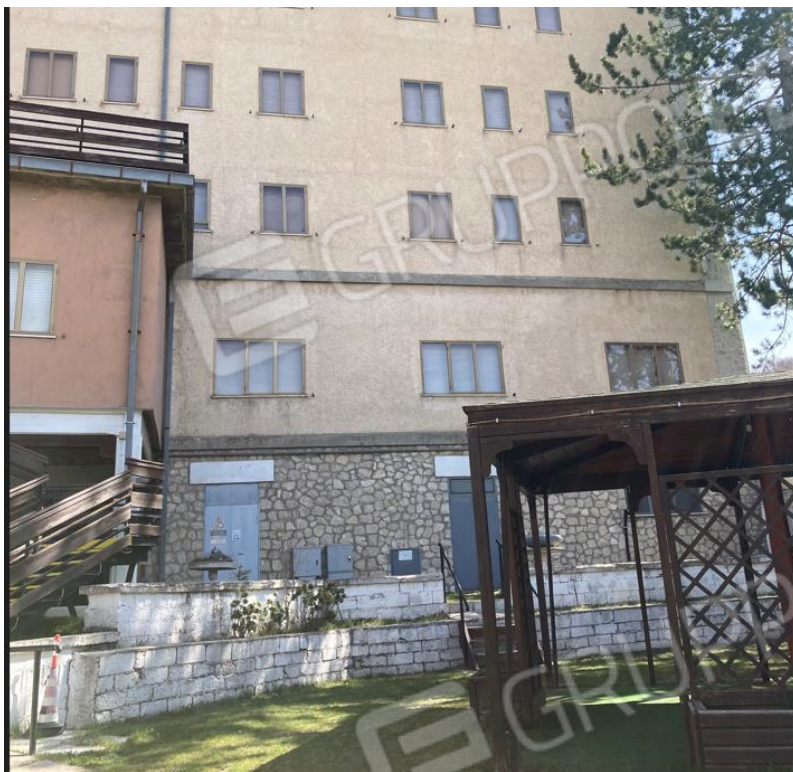
PIANO TERRA ACCESSO CABINA e-distribuzione
