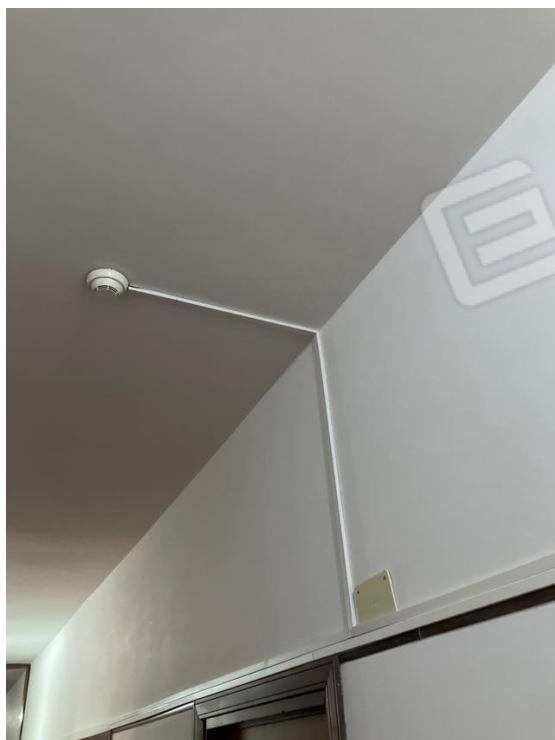
PIANO SECONDO PARTICOLARE IMPIANTO ALLARME ANTINCENDIO
