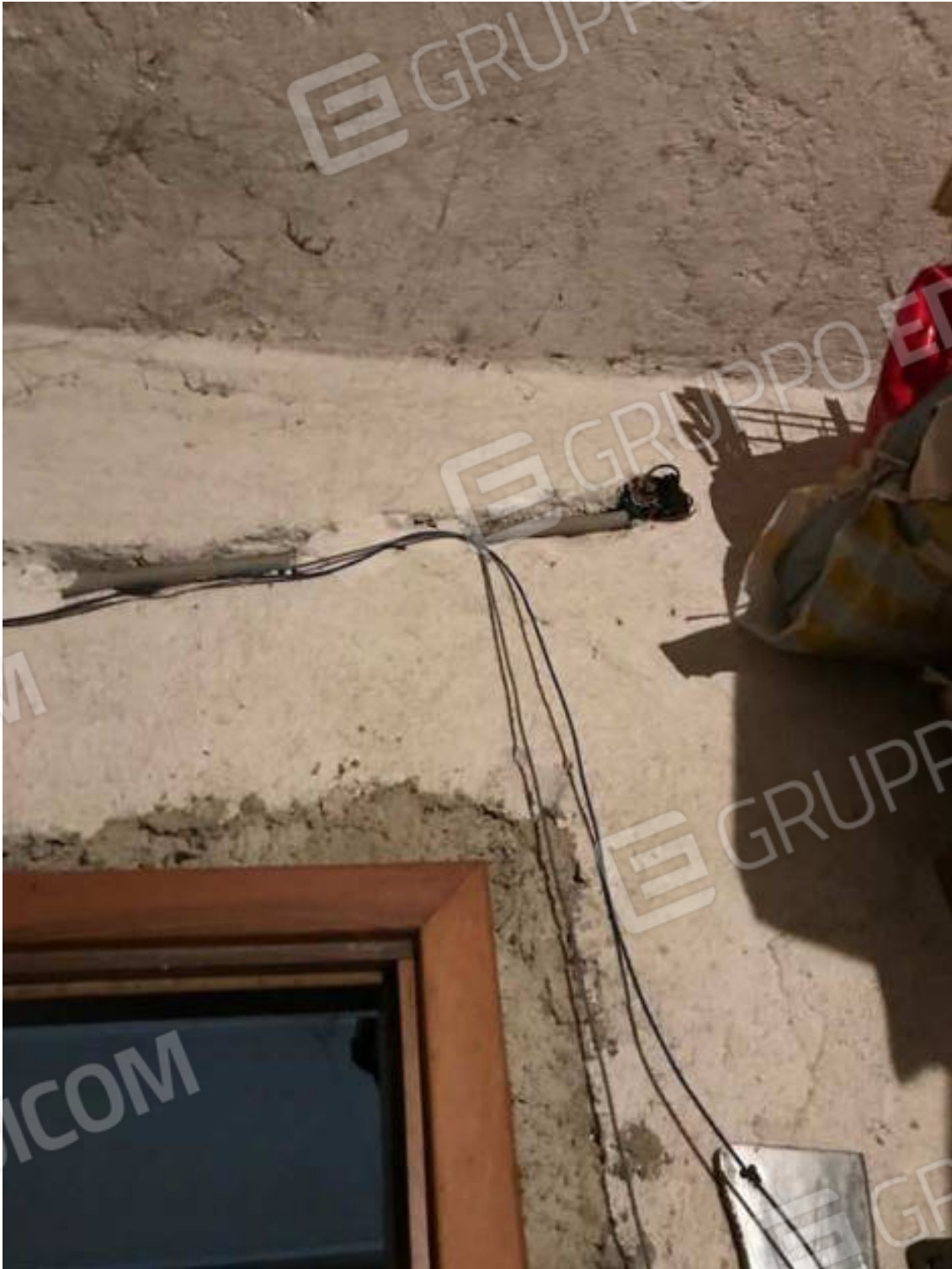
FOTO 30 – PARTICOLARE DI PUNTI DELL'IMPIANTO ELETTRICO DELLA CANTINA NON A NORMA CON FILI A VISTA E SCATOLE DI DERIVAZIONE APERTE
