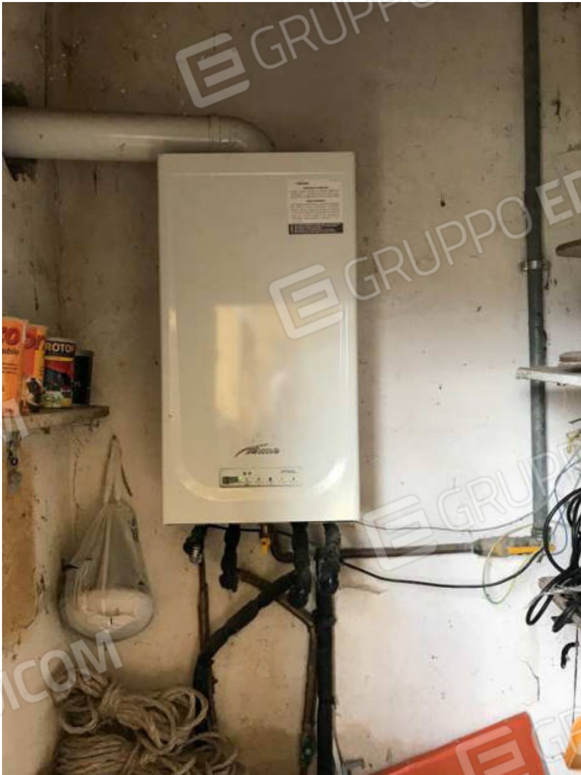
FOTO 32 – CALDAIA MURALE ESTERNA A SERVIZIO DEL LOTTO 1
