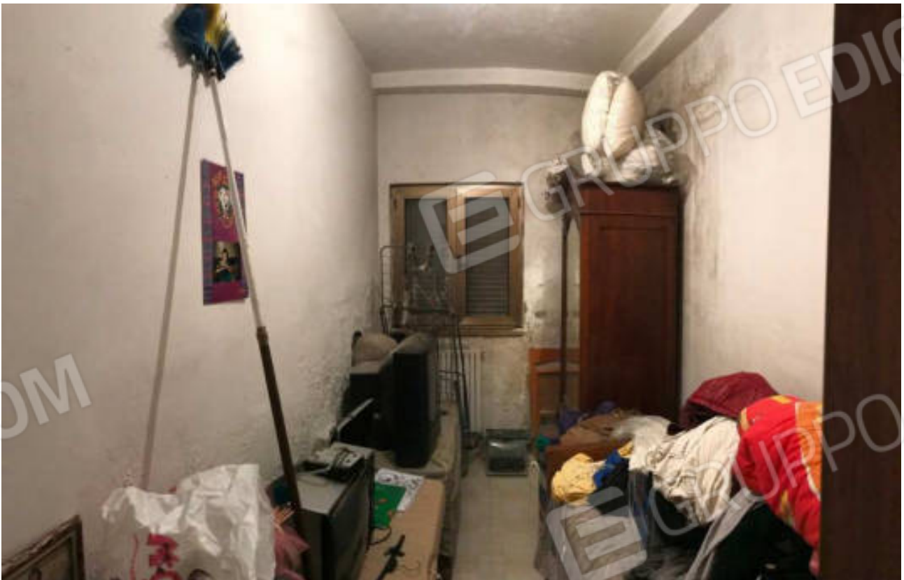
FOTO 25 – STANZA PLURIUSO. SI NOTINO, SULLE PARETI IN FONDO, LA PRESENZA DI UMIDITA' CON DIFFUSI DISTACCHI DI TINTEGGIATURA E INTONACO
