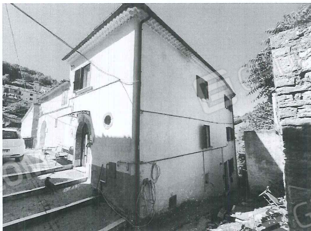
ANGOLO NORD EST FABBRICATO
