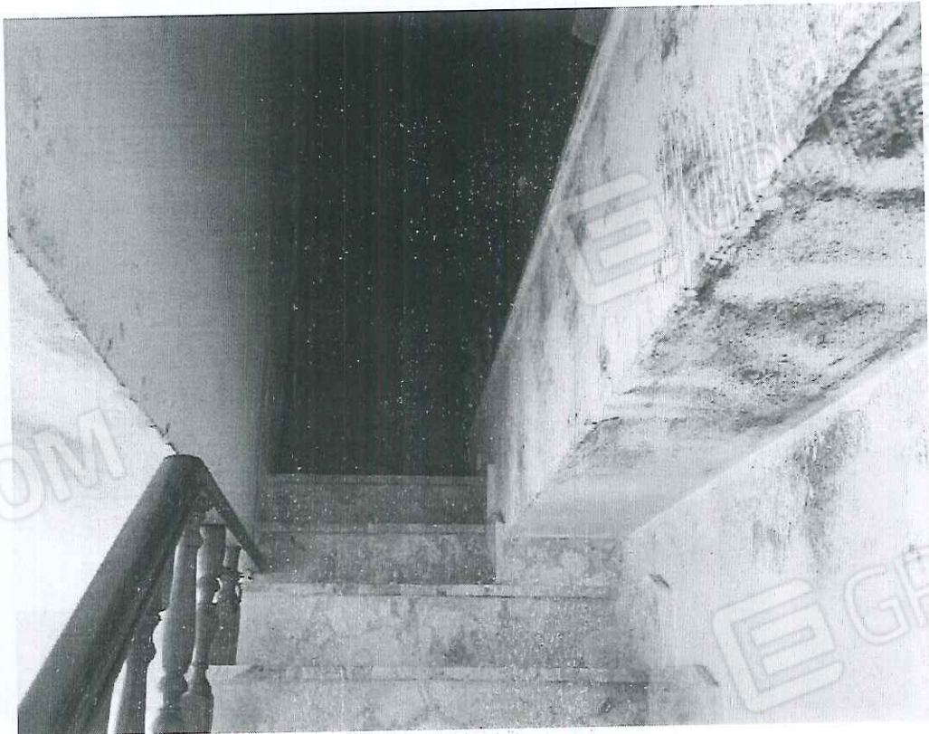
SCALA DI ACCESSO AL PIANO SEMINTERRATO
