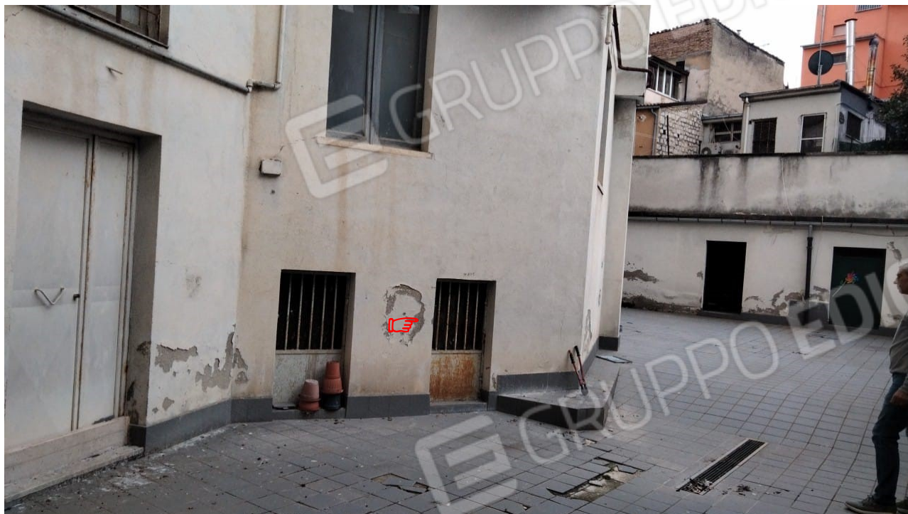
Vista dal cortile interno accesso alla cantina
