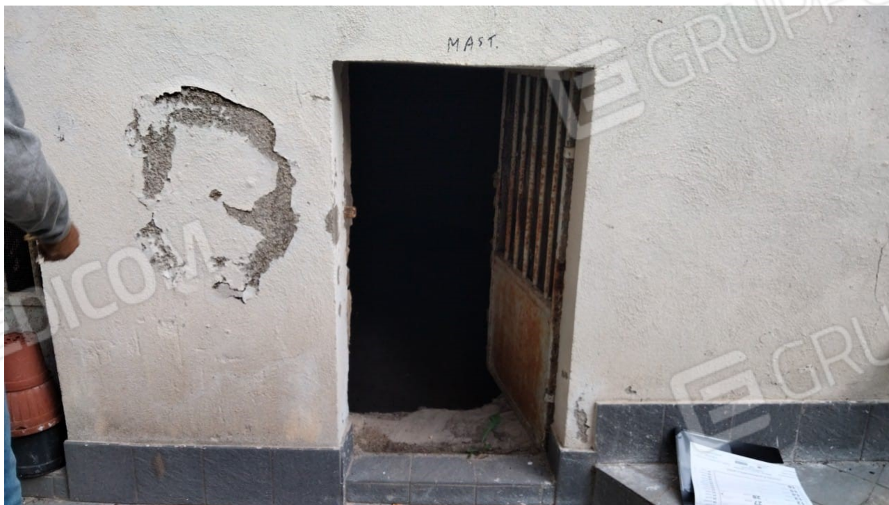
Vista dal cortile interno accesso alla cantina
