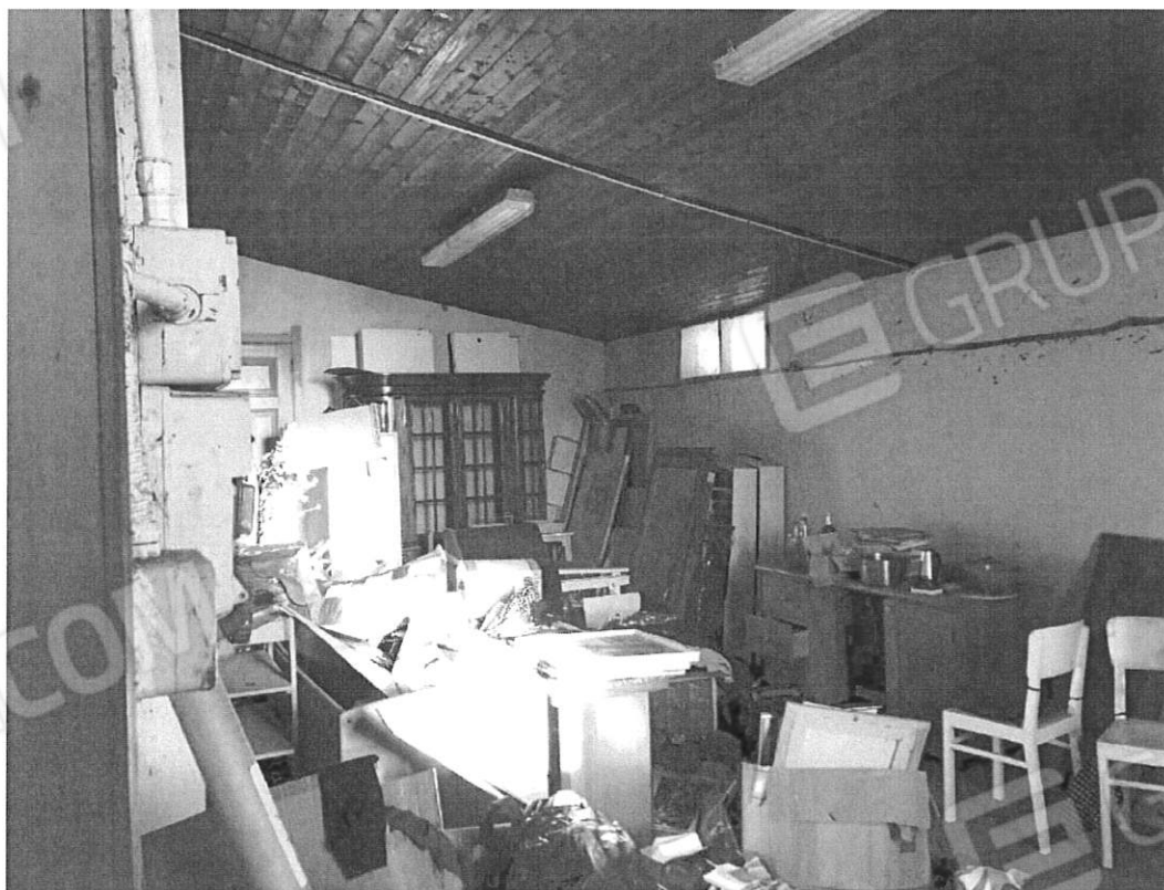
Figura 10 primo vano abusivo (sud)
