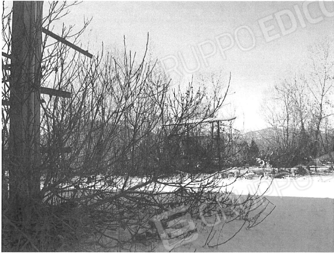
Figura 17 piccola tettoia posta sul nm. 252 da demolire
