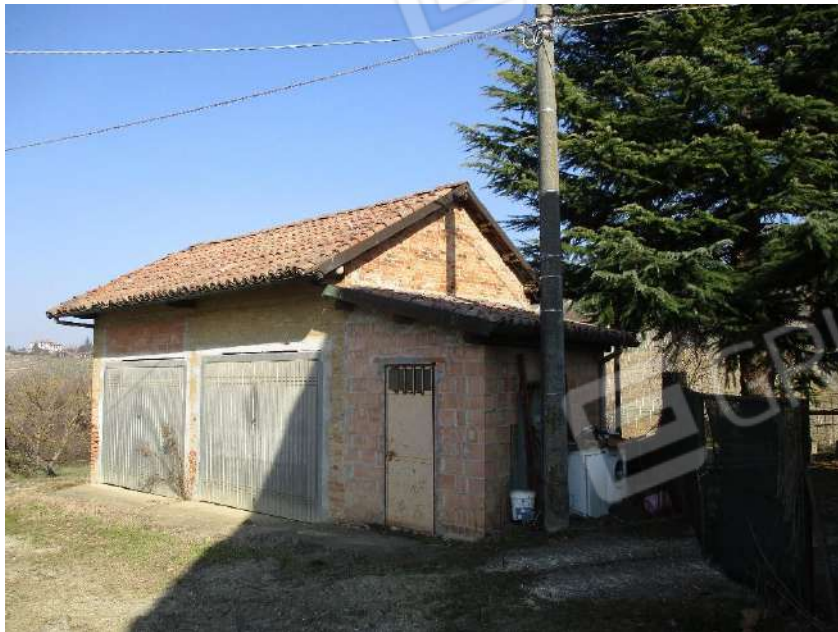
VISTA DEL LOCALE DI SGOMBERO SUL SEDIME
