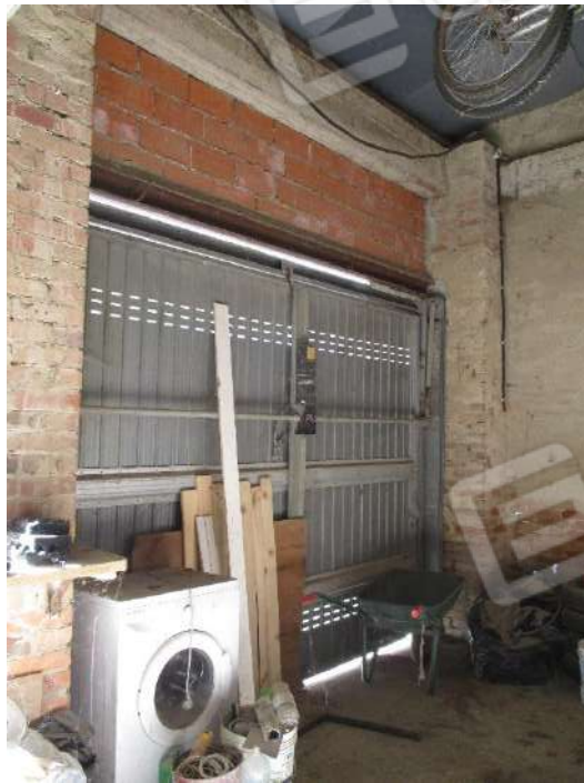
VISTA INTERNO LOCALE SGOMBERO
