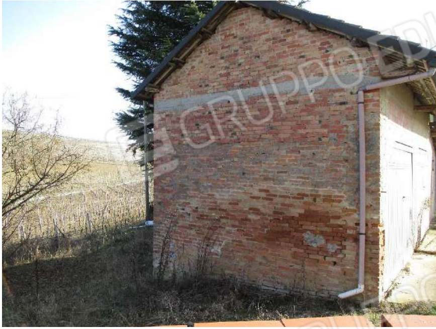
VISTA LATERALE DEL LOCALE DI SGOMBERO E TERRENO RETROSTANTE
