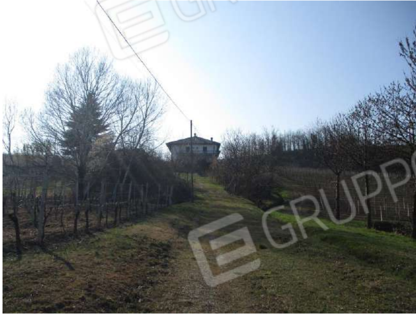
VISTA DEL FABBRICATO RESIDENZIALE DALLA STRADA DI ACCESSO E TERRENO
