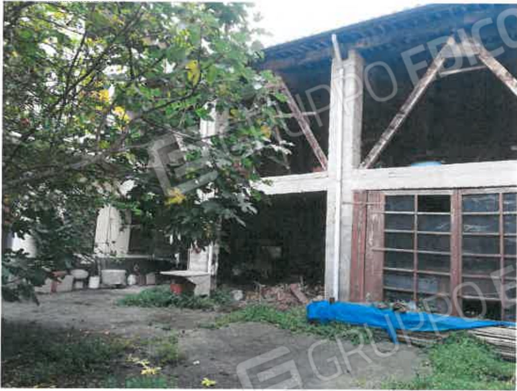
Foto n. 5_Locali di sgombero
