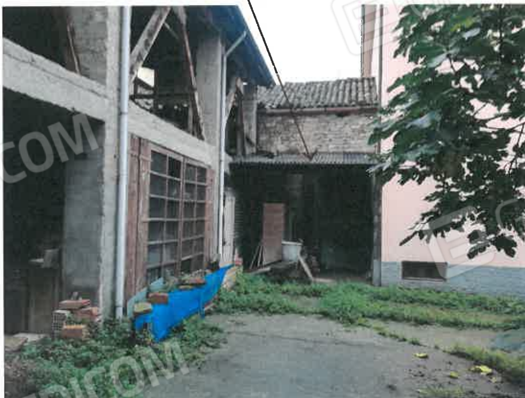
Foto n. 4_tettoia oggetto di sanatoria
