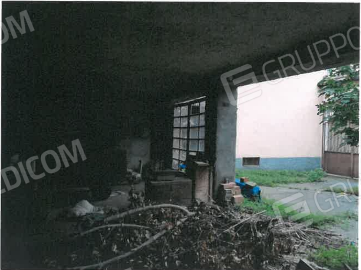
Foto n. 6_Locale di sgombero al piano terra
