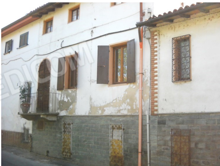
Prospetto da Via dei Mori
