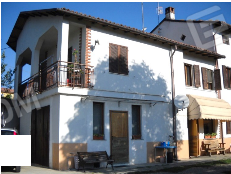
Prospetto da cortile interno
