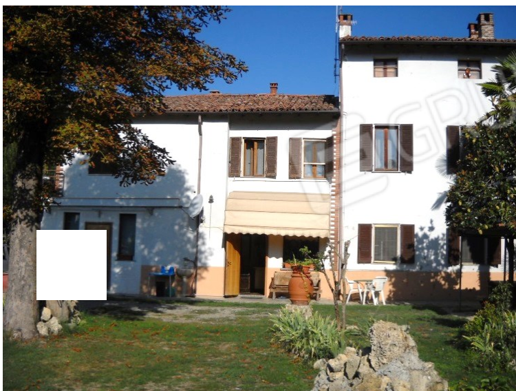
Prospetto da cortile interno
