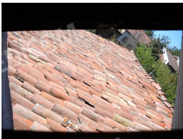
Manto di copertura in coppi
