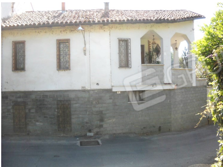
Prospetto da Via dei Mori
