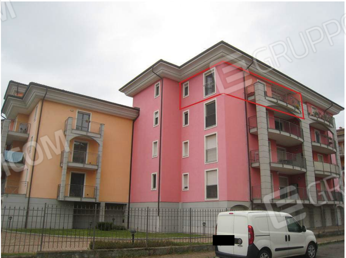
Fronte su via A. Rossa
