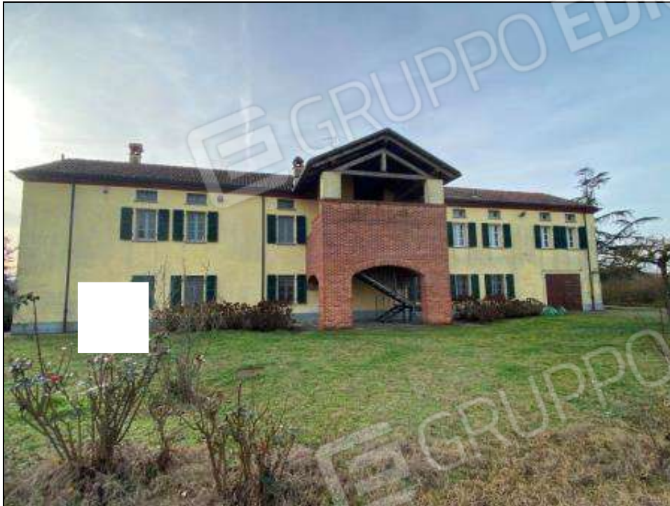
Immagine 7: Vista Fabbricato principale lato Nord
