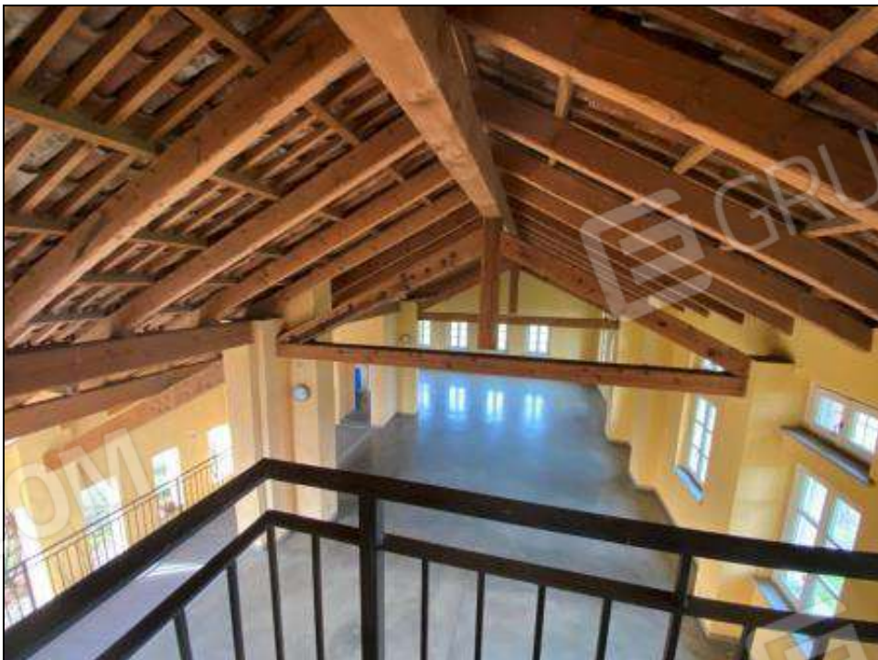
Immagine 50: dal balcone su portico – Piano Secondo
