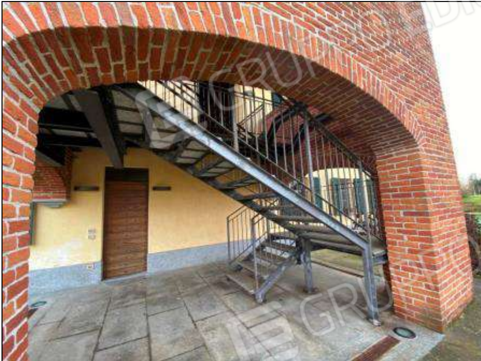
Immagine 16: Vano scala esterno lato Nord
