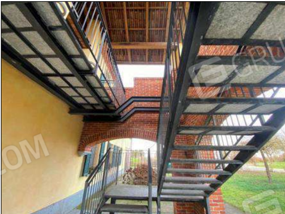
Immagine 17: Vano scala esterno lato Nord
