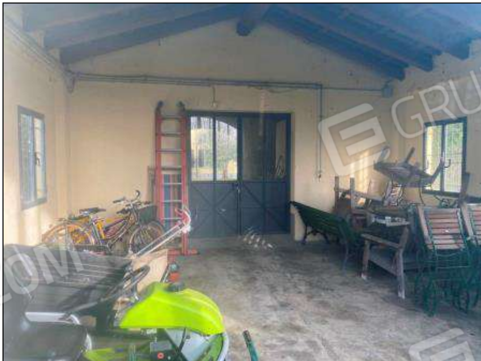
Immagine 55: Locale deposito – Piano Terra
