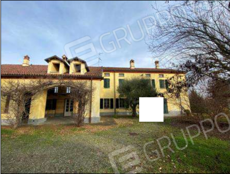
Immagine 9: Vista Fabbricato principale lato Sud
