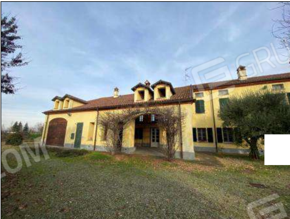
Immagine 10: Vista Fabbricato principale lato Sud
