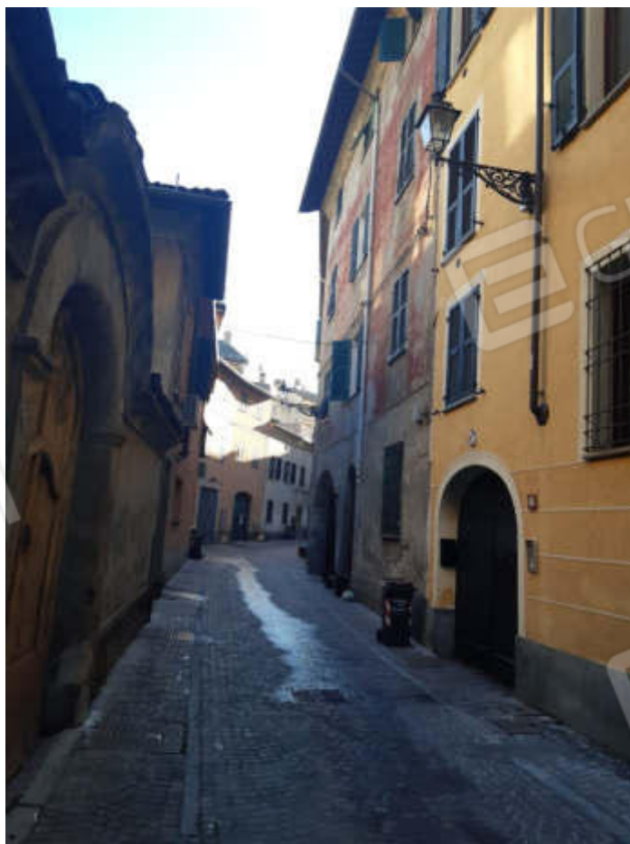
Vista dalla strada pubblica del fabbricato urbano comprendente l'U.I.U. oggetto di esecuzione
