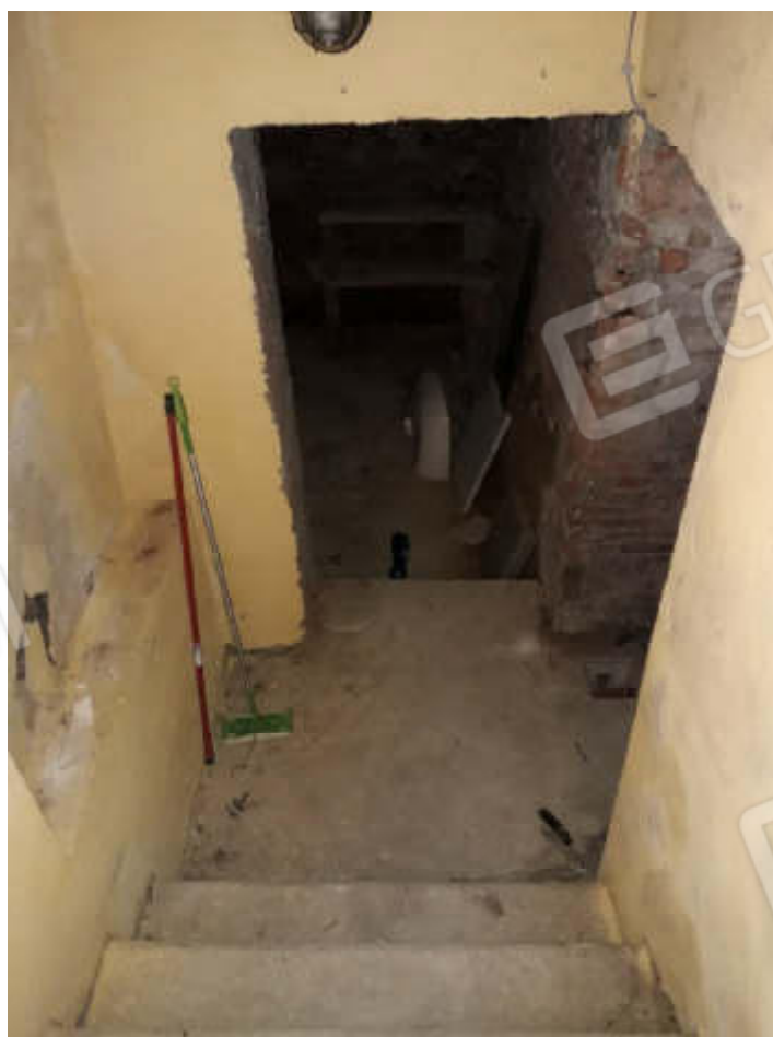
Vista scala di accesso interna di accesso ai locali pertinenziali destinati a cantina posti in piano primo sottostrada
