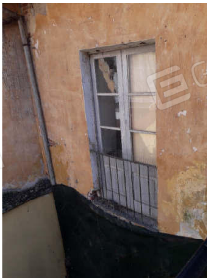
Vista dal lastrico solare condominiale delle facciate esterne della U.I.U. oggetto di stima
