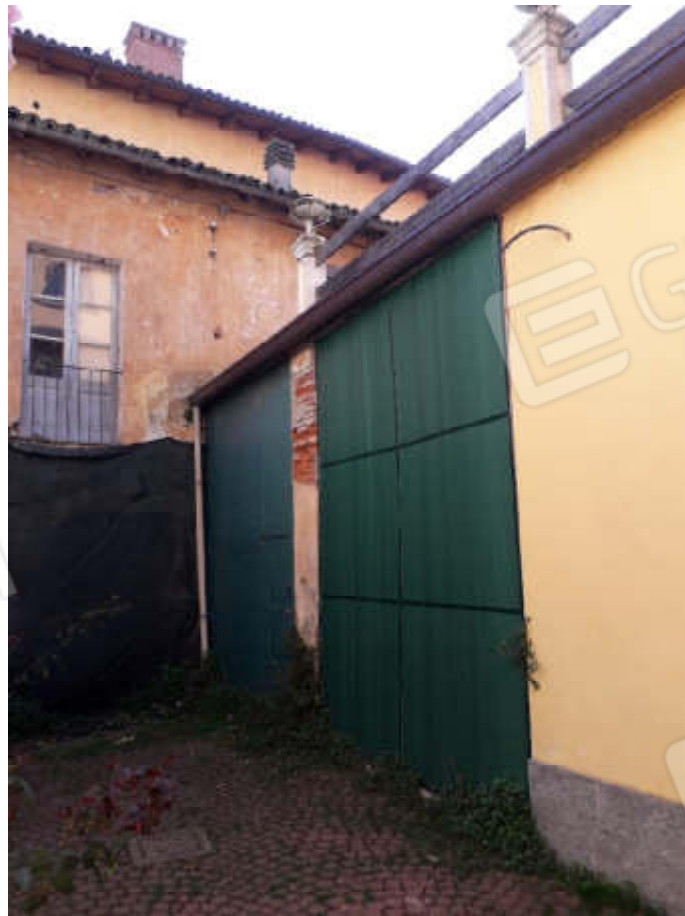
Vista dal cortile interno delle facciate esterne della U.I.U. oggetto di stima
