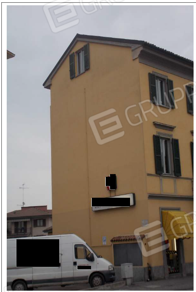
Fotografia n. 2 = Vista del prospetto EST del Condominio "Residenza Europa"
