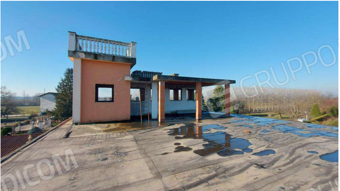
Foto 14 – Vista della torretta dal lastrico solare al piano 2 (sub 2 corpo C)
