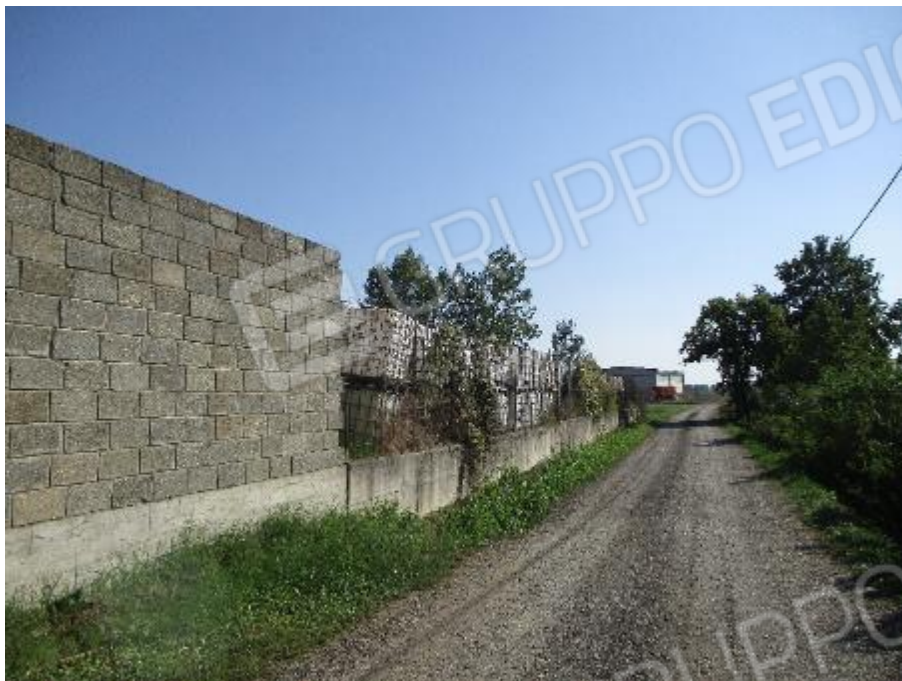
Vista del muro di recinzione in cls del lotto - lato Ovest (da via Pavesa)
