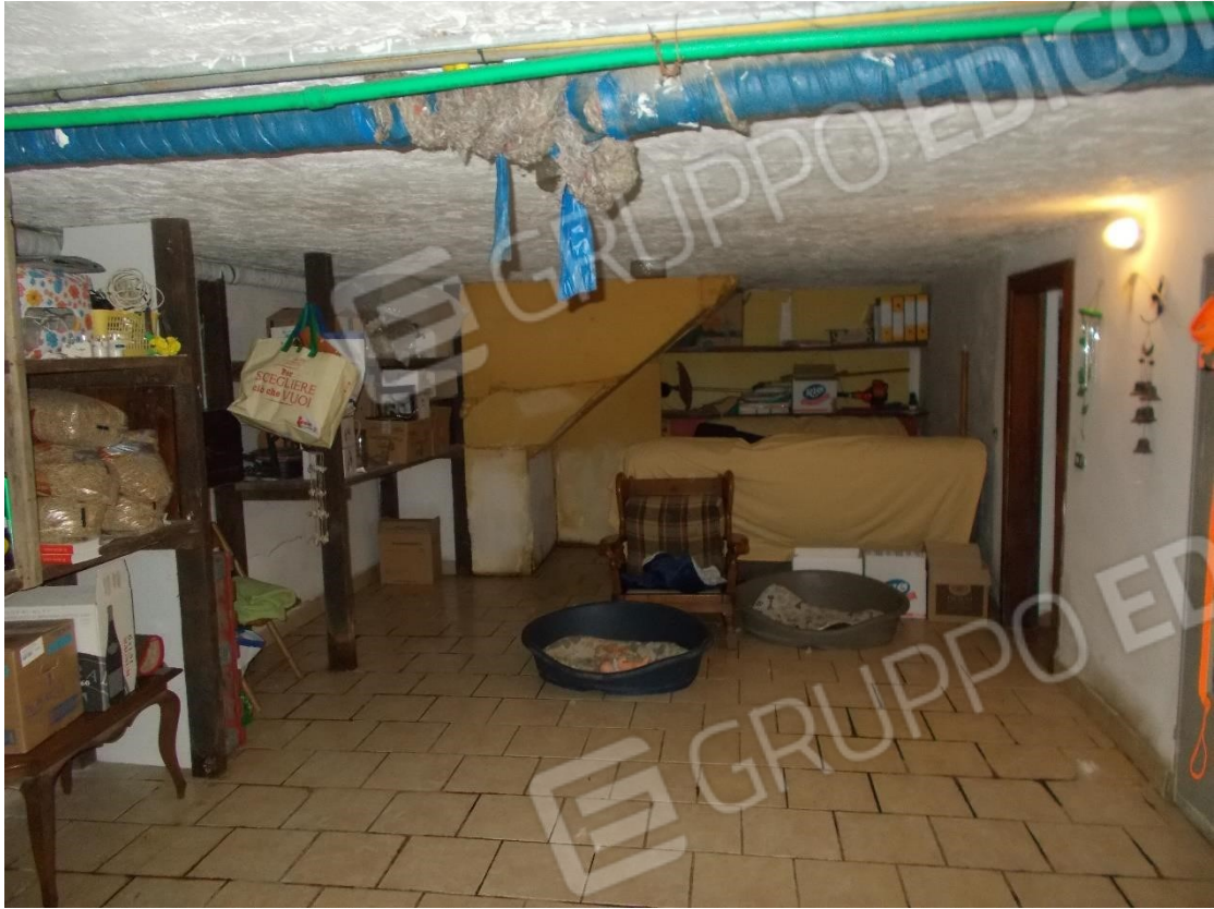
Foto 16. Particolare Garage al piano Terra
