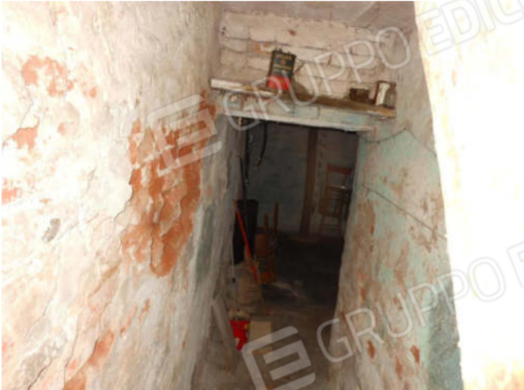
Foto 47 Scala accesso piano seminterrato Lotto 2
