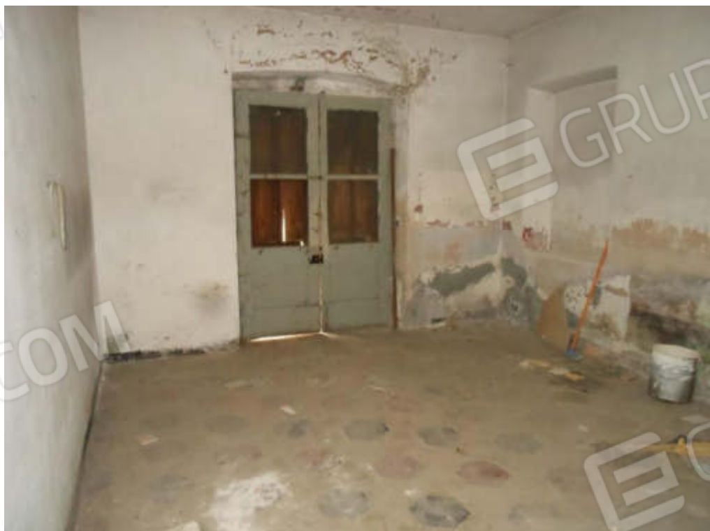
Foto 40 Camera piano terra Lotto 2
