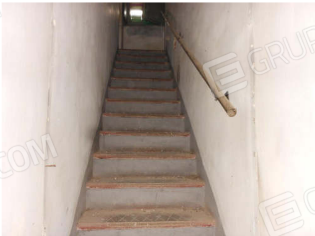
Foto 42 Scala accesso piano primo Lotto 2
