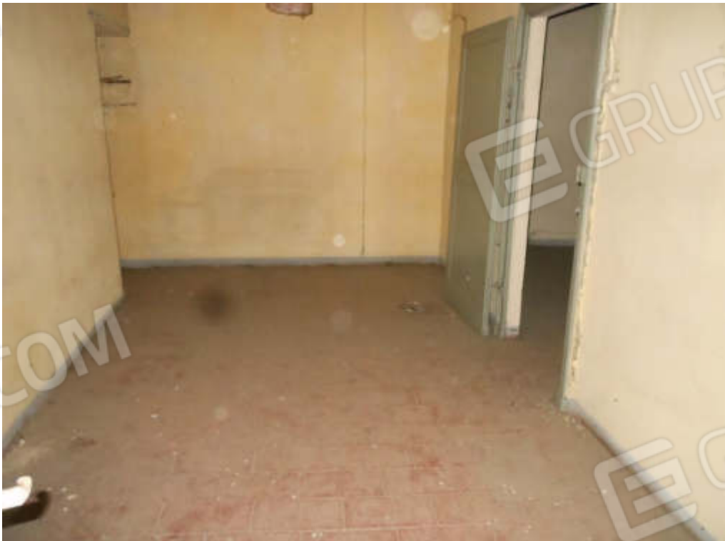
Foto 44 Camera piano primo Lotto 2
