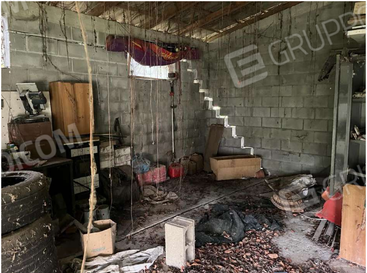
Fabbricato abusivo con particolare criticità
