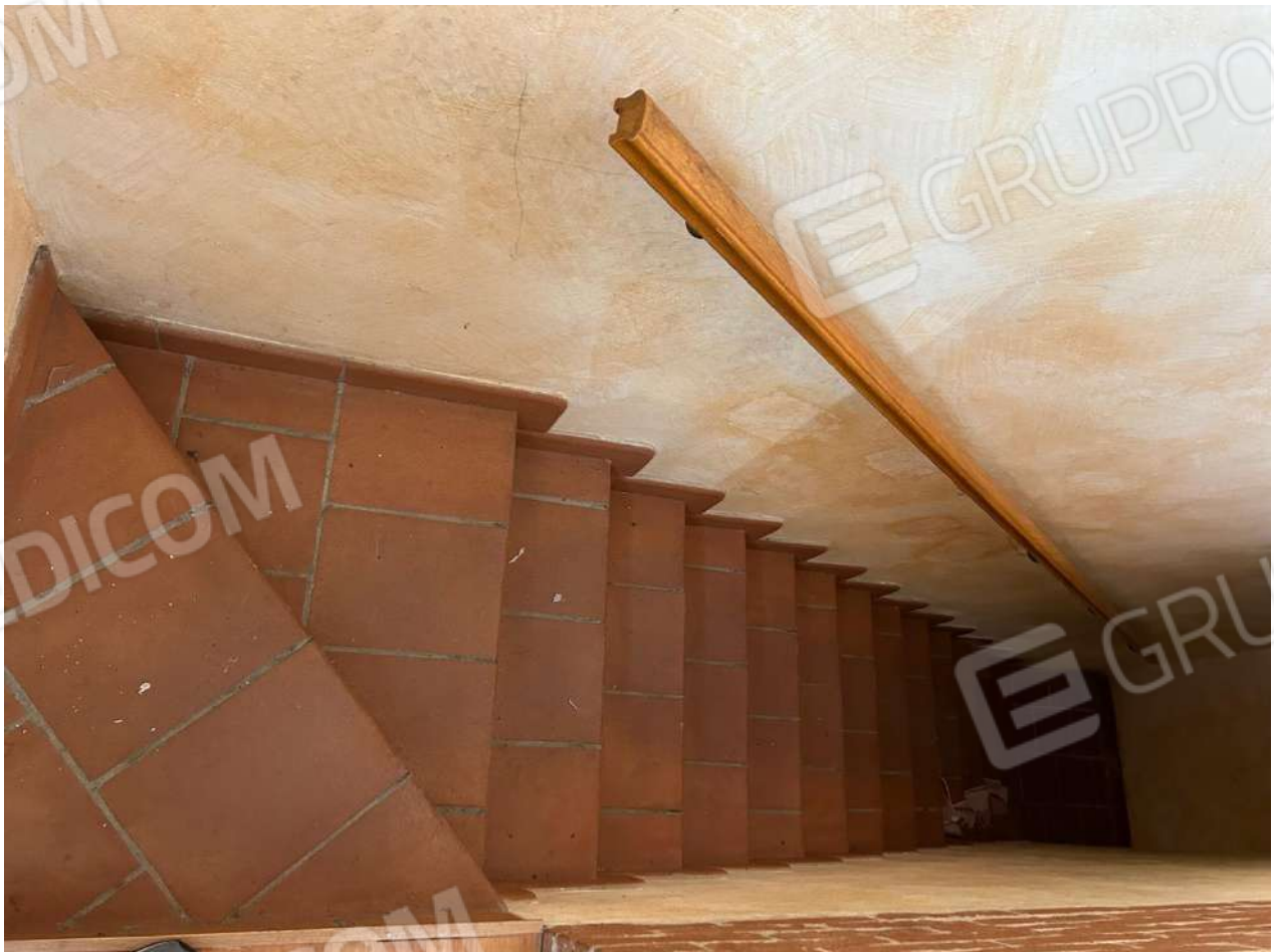
Scala di accesso al piano primo
