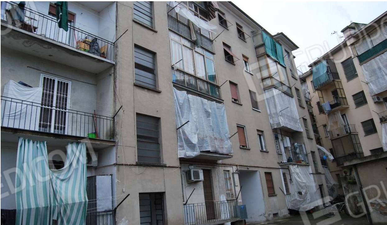
Facciata esterna fabbricato residenziale interno cortile e vano scala foto 3-4-5)
