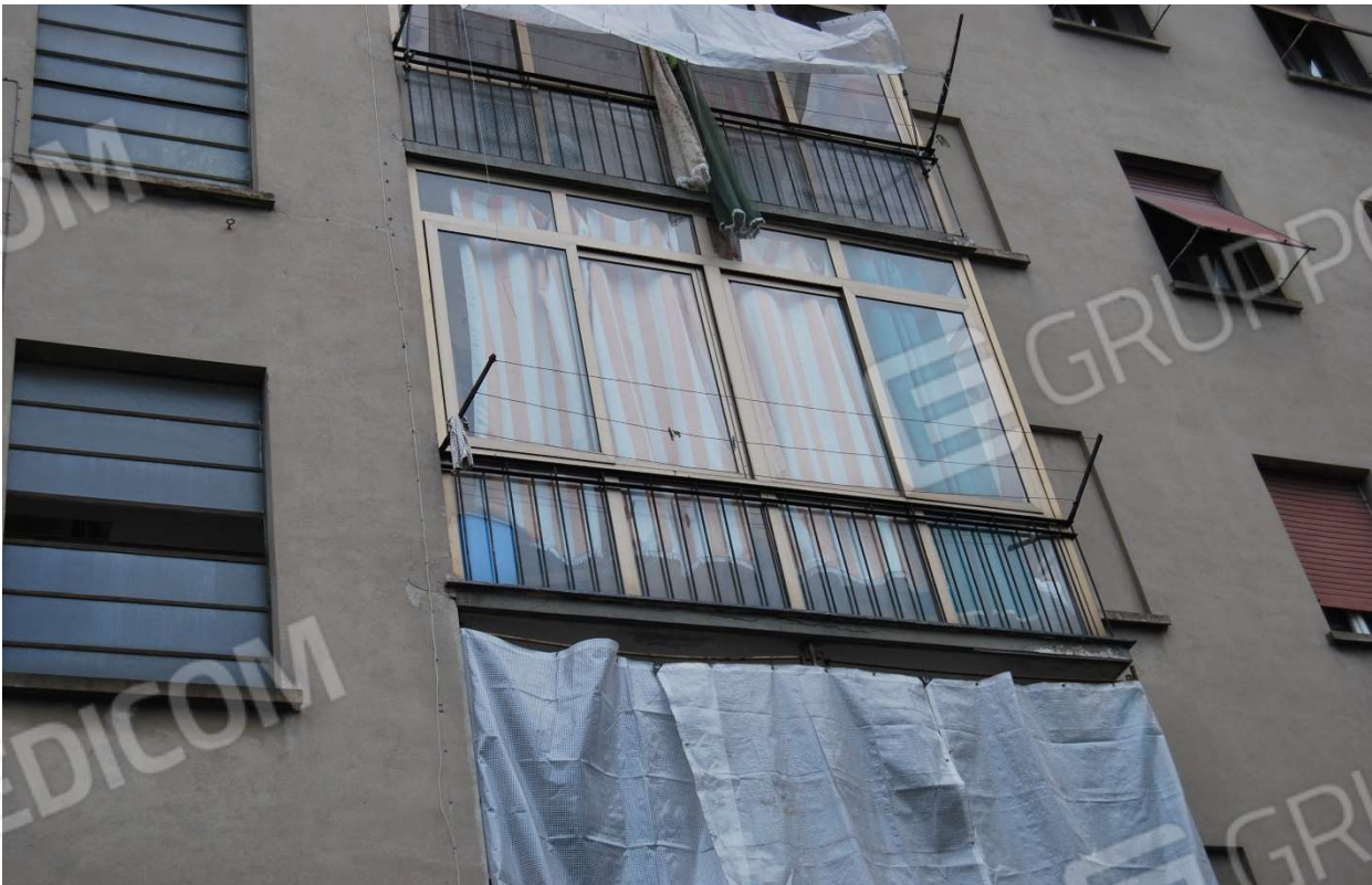
Facciate esterne fabbricato residenziale su via G. Ferraris n 6 (AL) e interno cortile foto 1-2)
