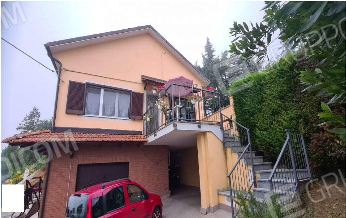
Fotografia 18: Abitazione Valle san bartolomeo map. 394 sub. 1 prospetto est
