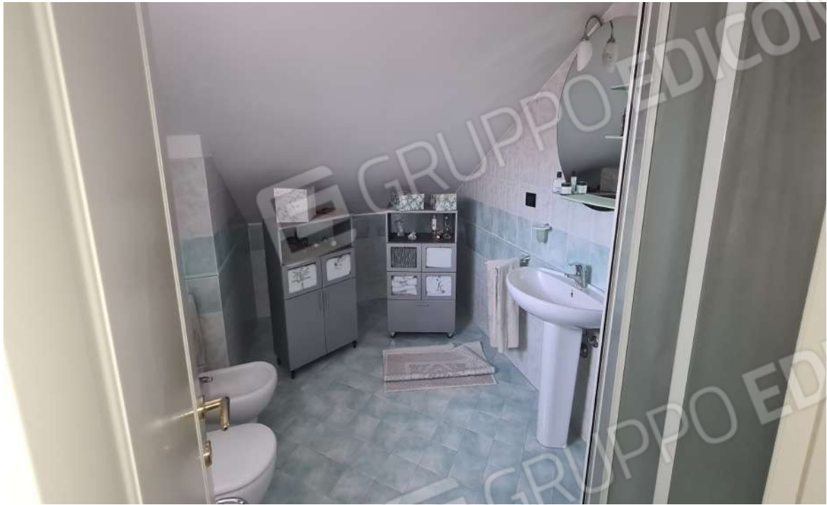
Fotografia 13: locale di sgombero sub. 15 (servizio igienico non autorizzato)
