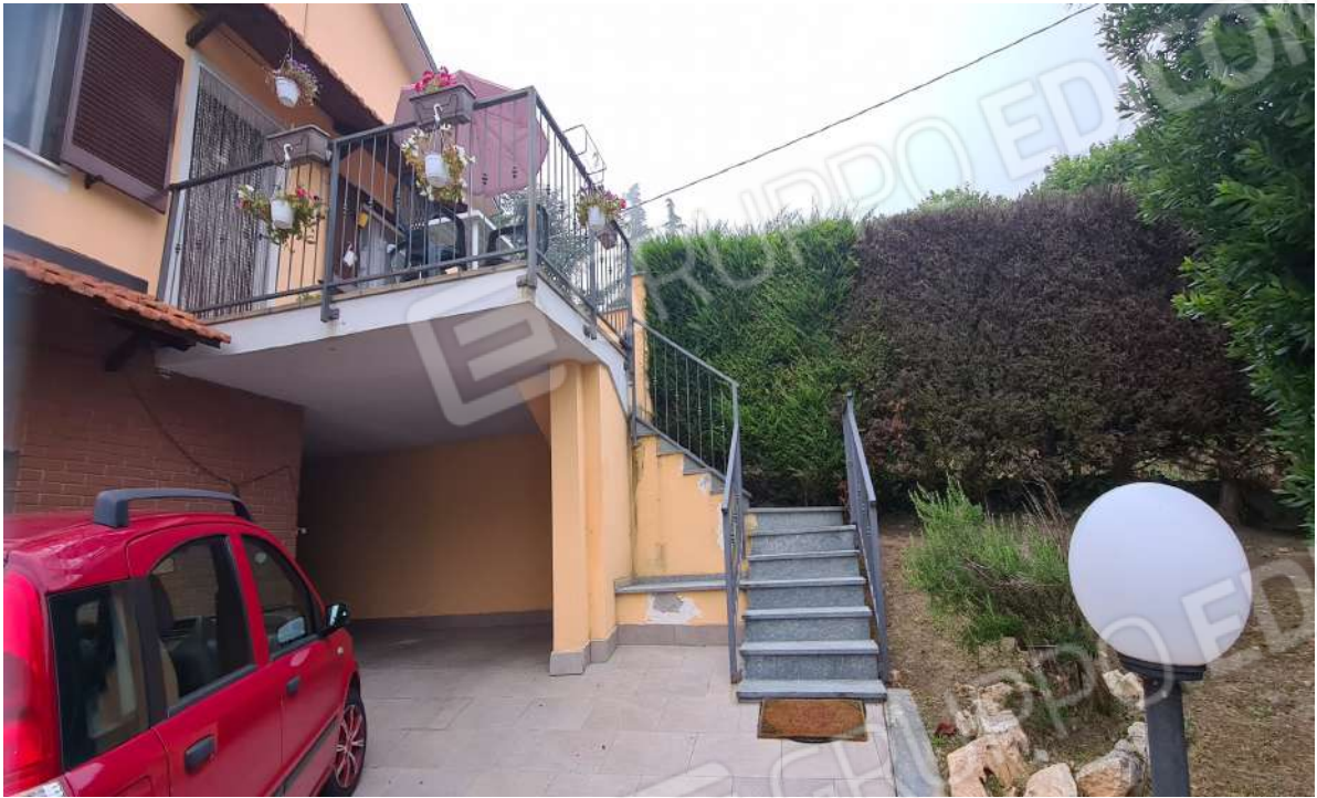
Fotografia 27: scala esterna di accesso al terrazzo piano primo
