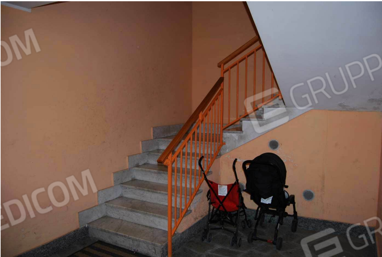
Ingresso pedonale e vano scala condominiale foto 3-4)
