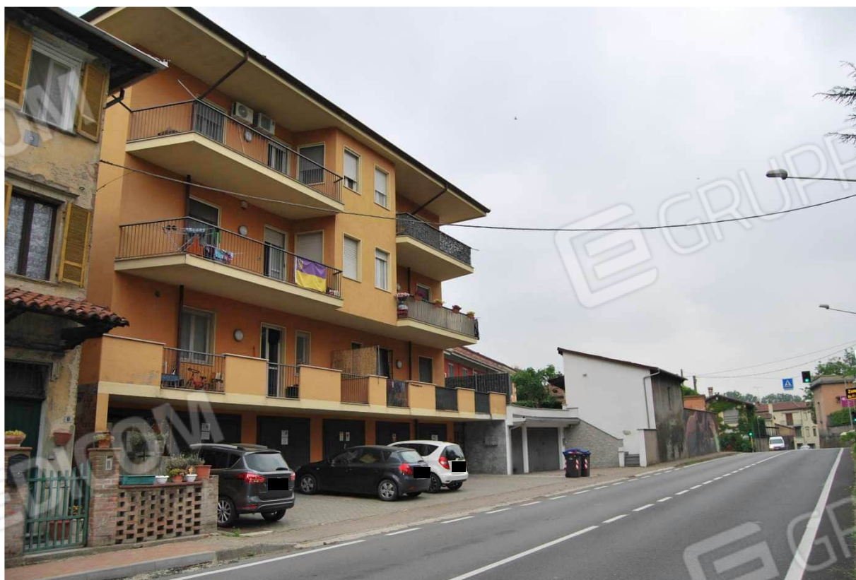
Facciata esterna fabbricato residenziale su strada Padana ovest n 6/A Quattordio. foto 1-2)
