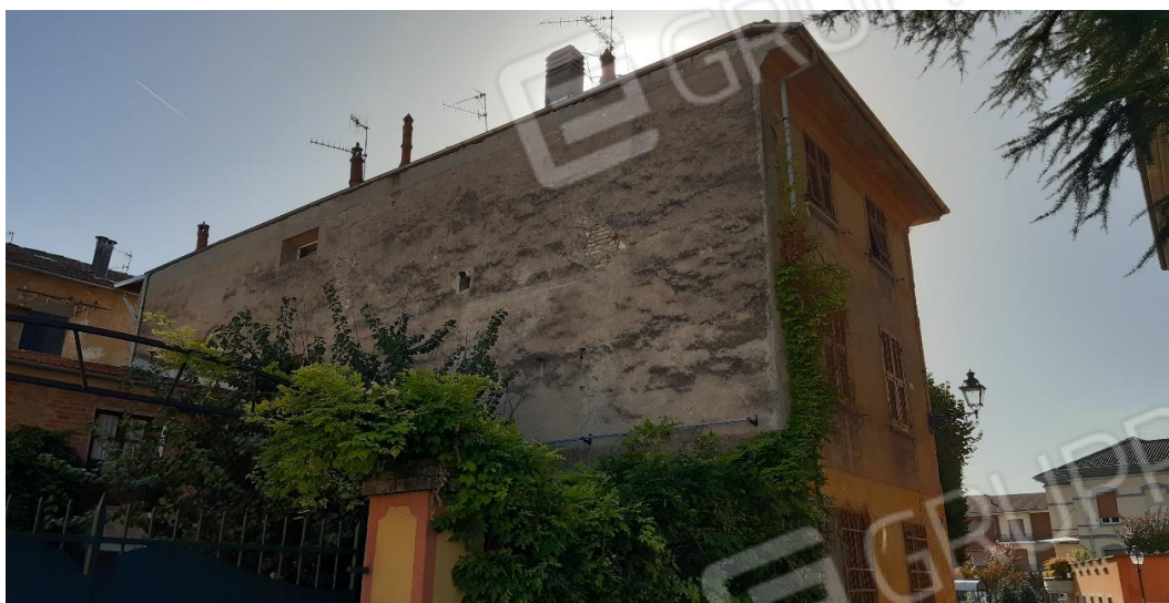
Vista del retro del fabbricato
