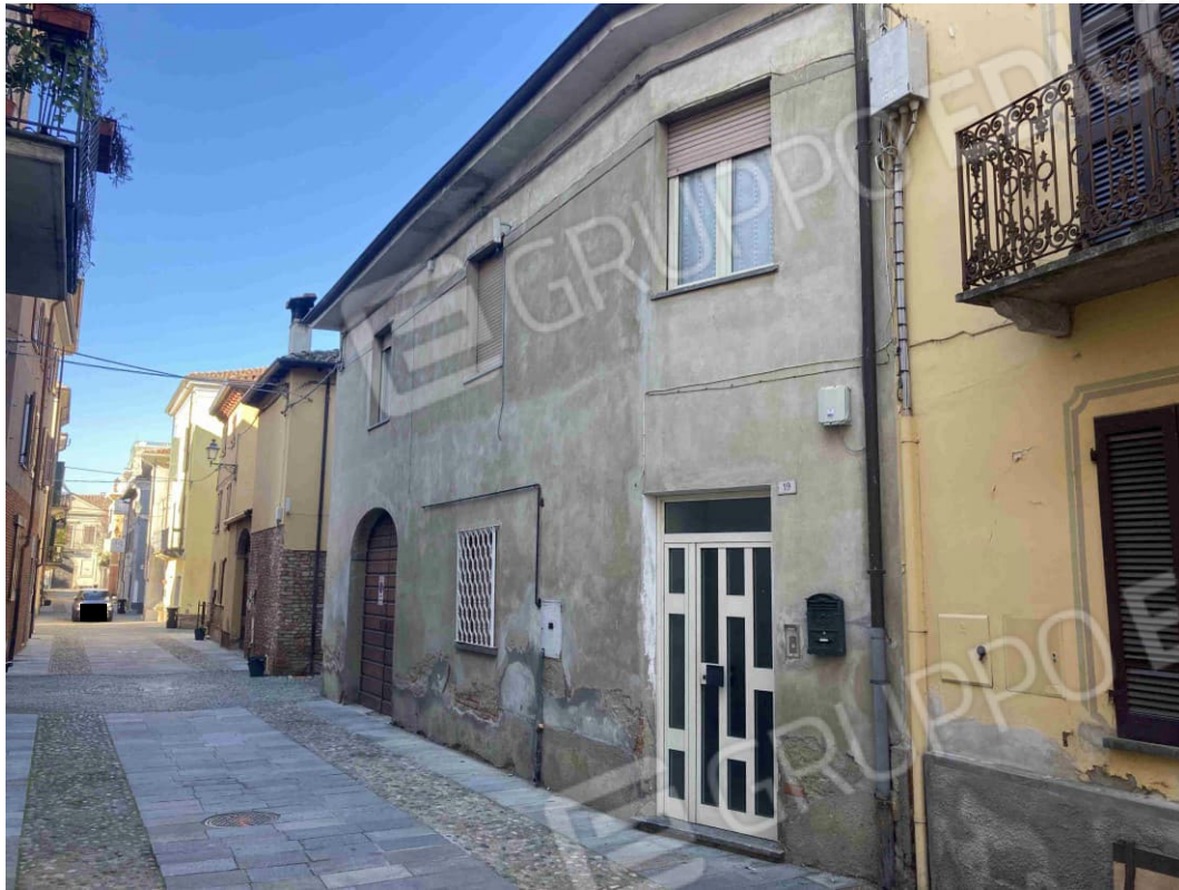
Foto 1 – Prospetto da Via Roma
