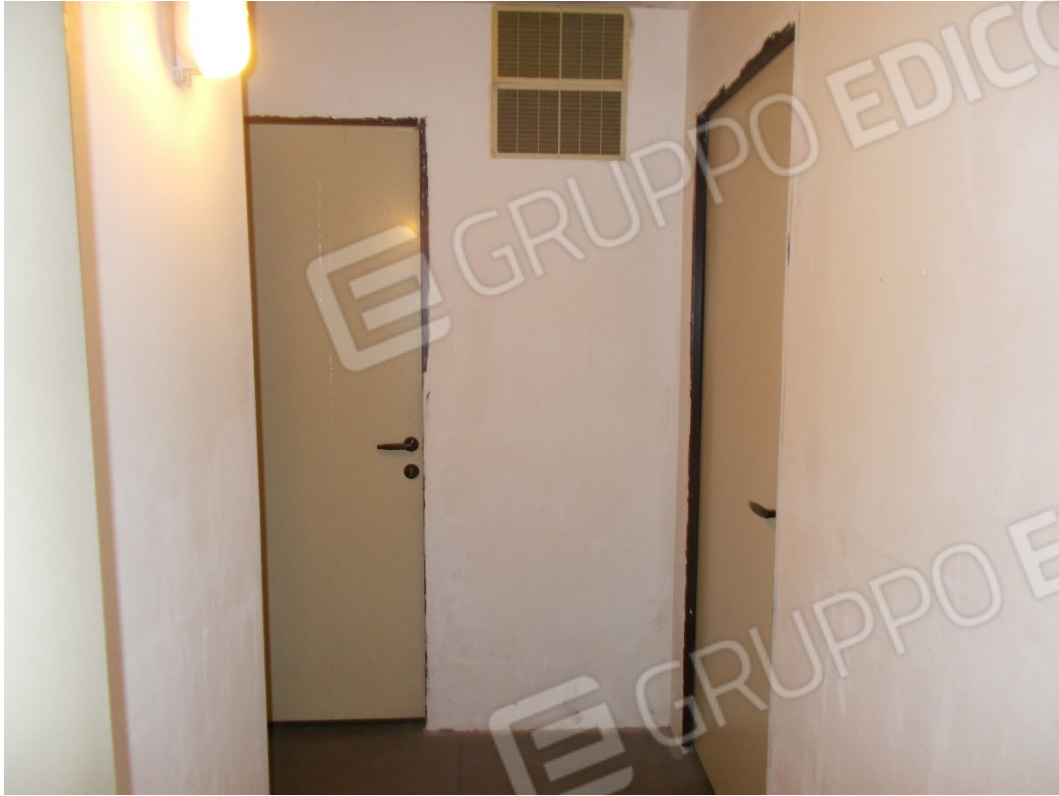
Foto 7. Particolare accesso alla cantina di pertinenza dell'alloggio (sub. 43) e all'adiacente locale magazzino (sub. 36)
