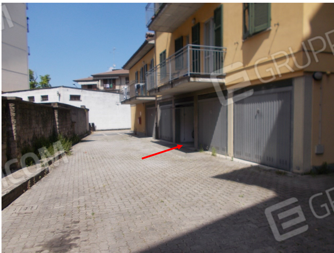
Foto 11. Box auto al piano primo interrato (sub. 30) – con accesso dal sedime comune
