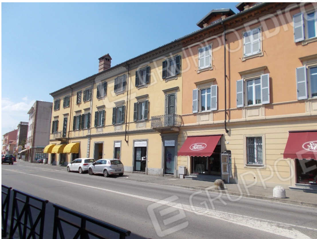
Foto 1. Immobile residenziale (commerciale al piano terra) – Prospetto su Largo Europa
