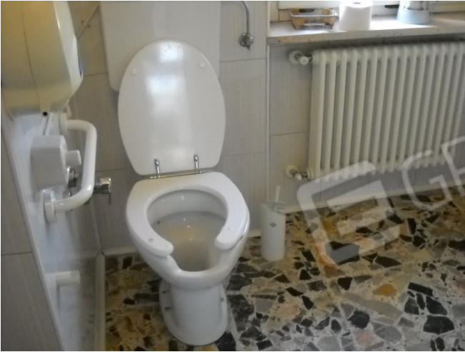
Locale commerciale servizi clienti (sub.34)
