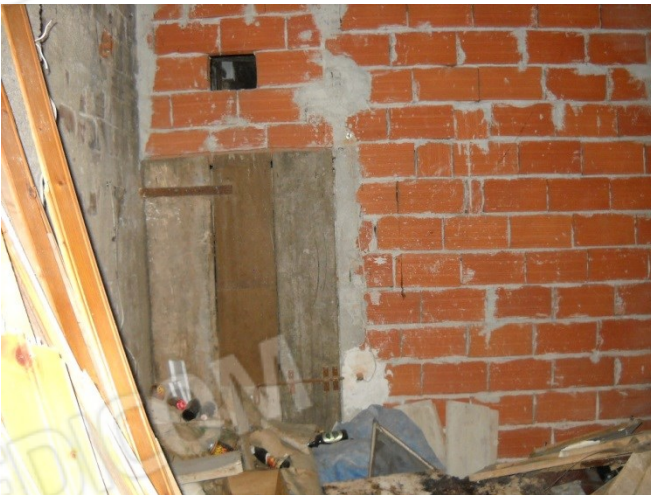
Locale cantina in piano seminterrato (sub.40)
