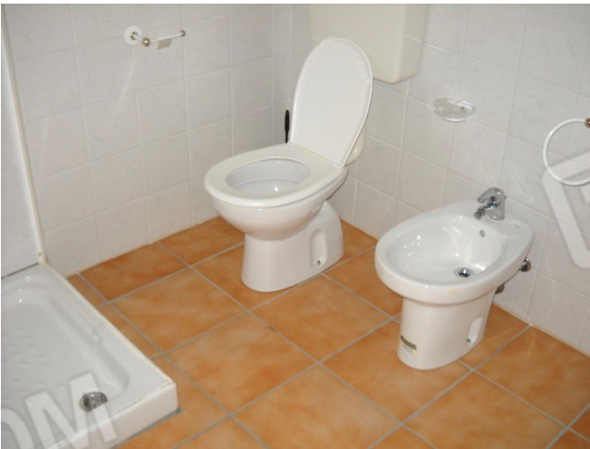
Bagno abusivo seminterrato
