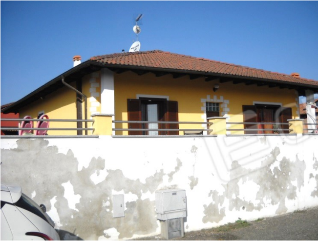
Prospetto lato strada
