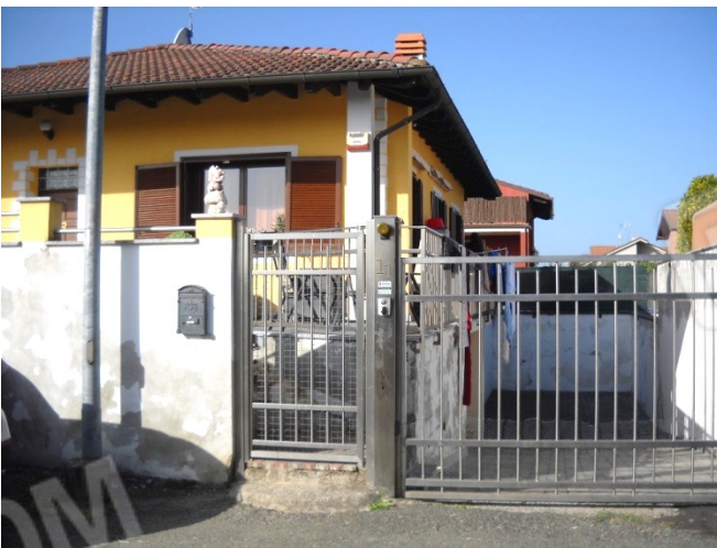
Ingressi pedonale e carroia
