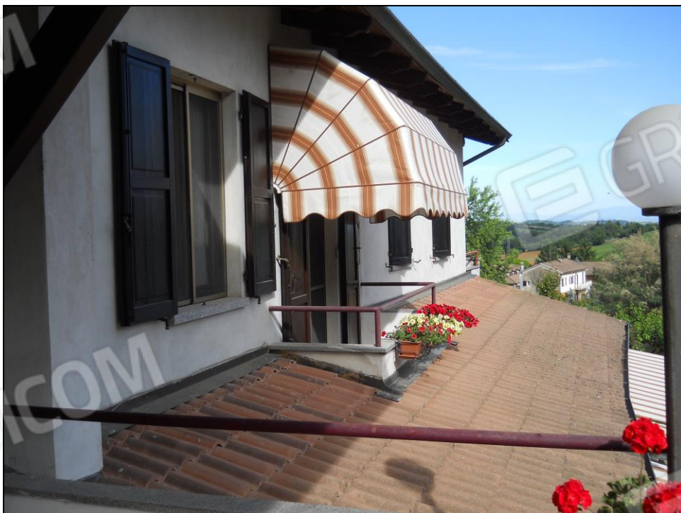
Immagine 5: Vista piano primo (2° f.t.)
