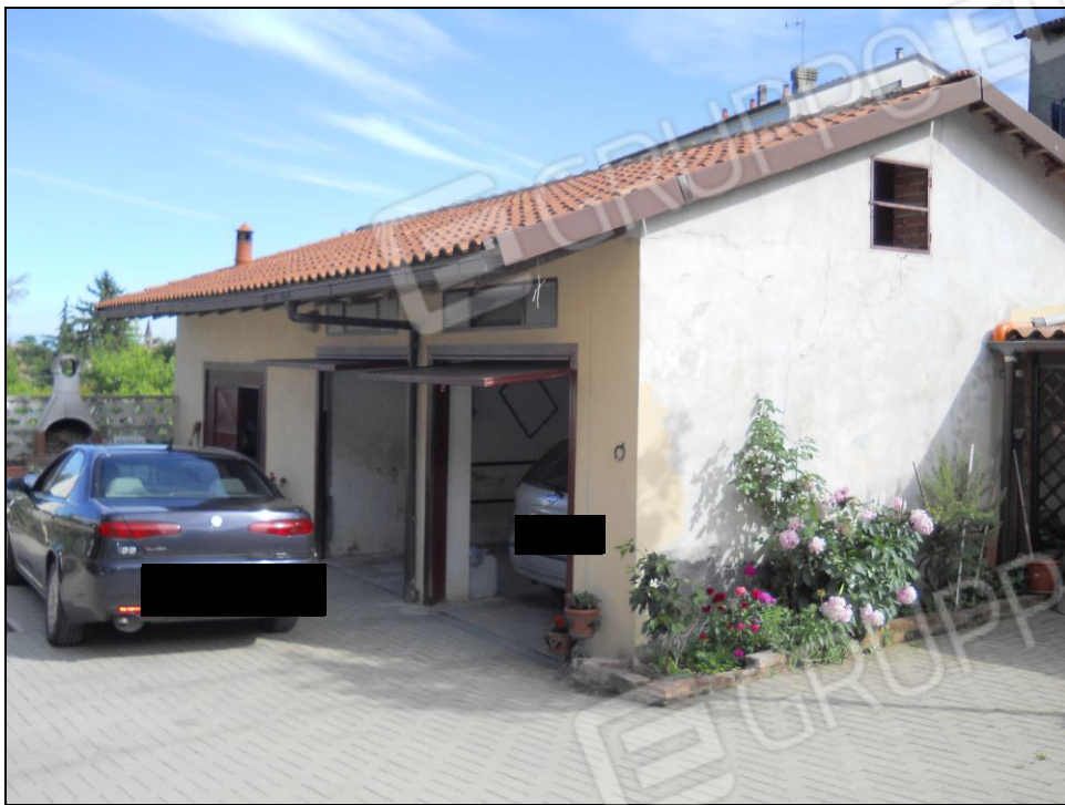
Immagine 4: Vista esterna del box auto
