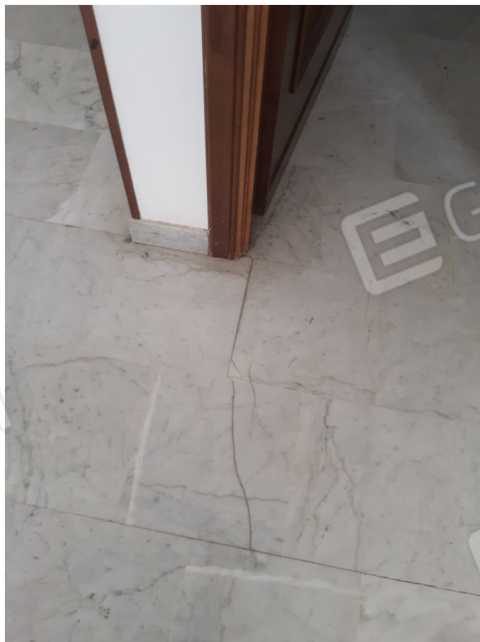
Vista particolare fessurazioni e spaccature su pavimentazioni
