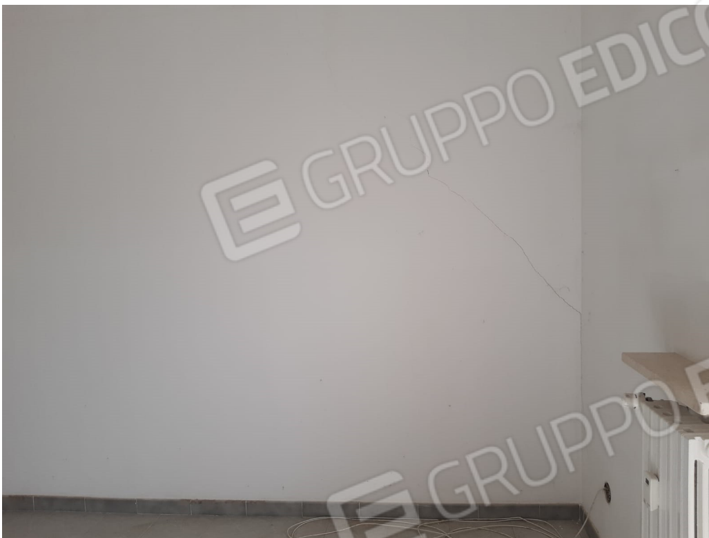
Vista particolare fessurazioni intonaci su superficie verticali
