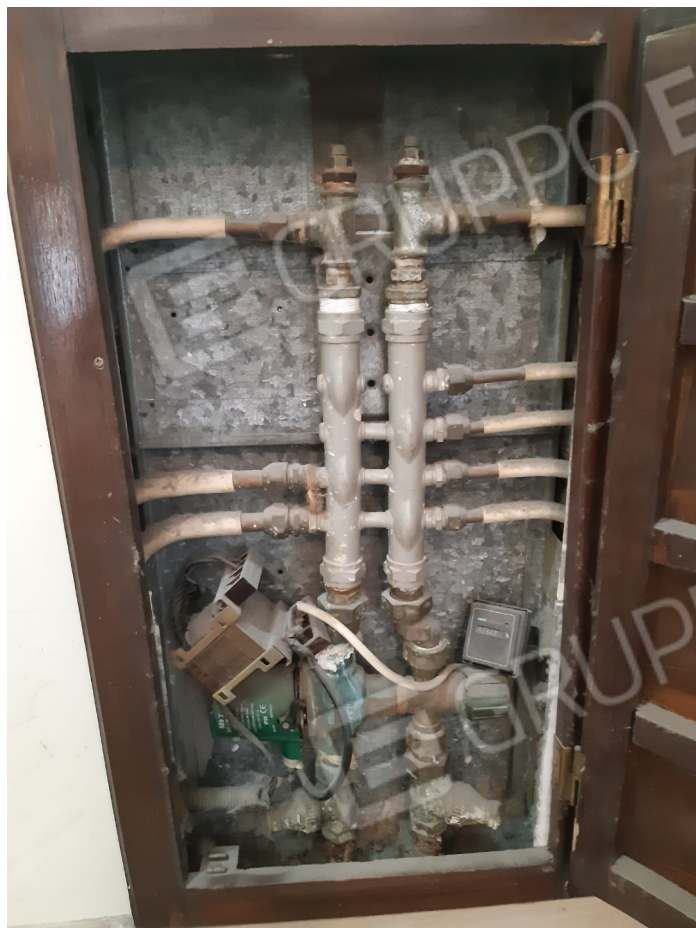
Vista particolare dotazione utenze: collettore distribuzione impianto riscaldamento
