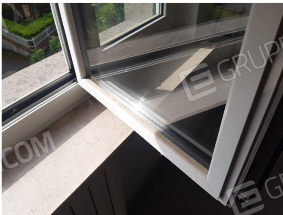
Vista particolare tipologia serramenti a servizio dei vani di abitazione
