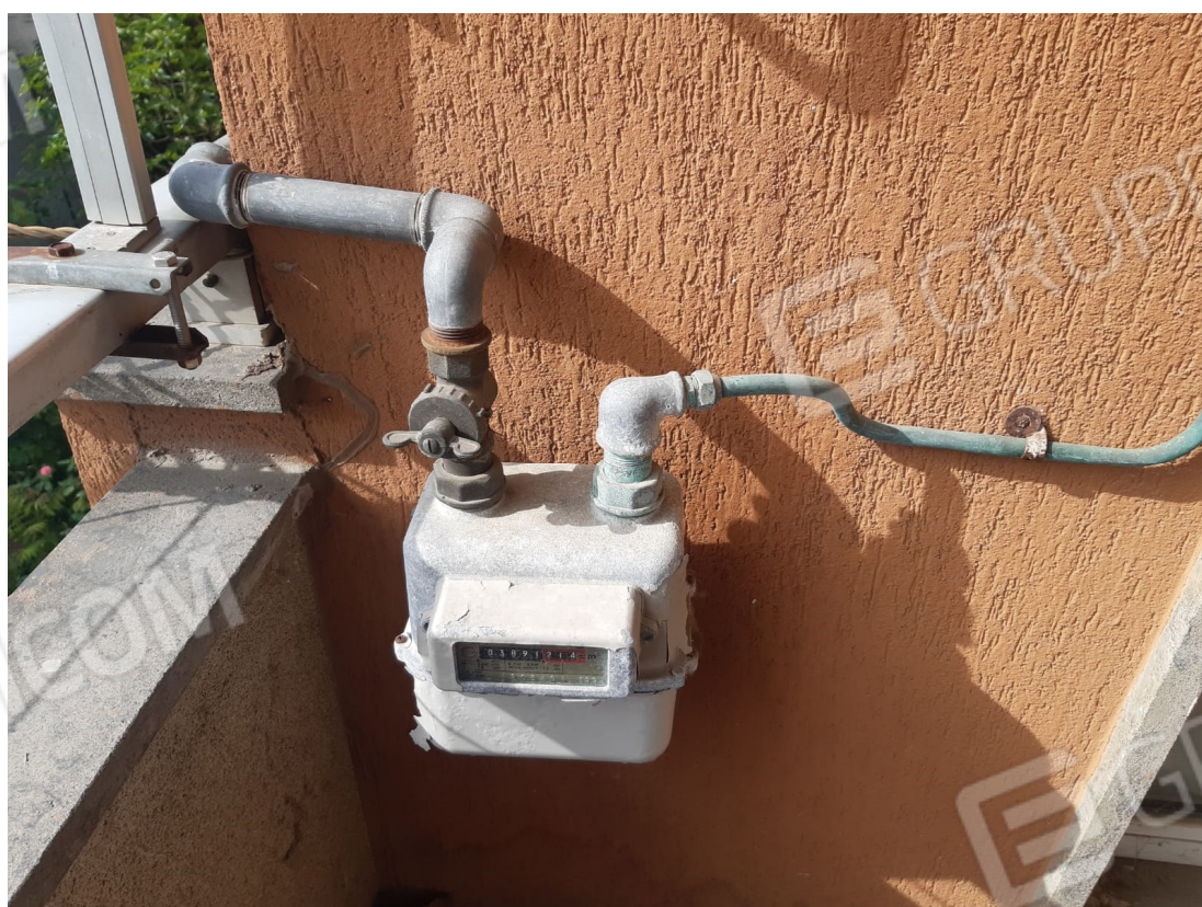
Vista particolare dotazione utenze: contatore impianto gas - metano
