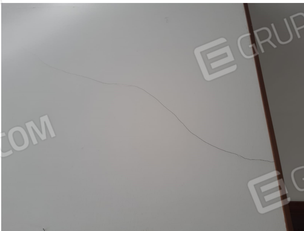
Vista particolare fessurazioni intonaci su superficie verticali
