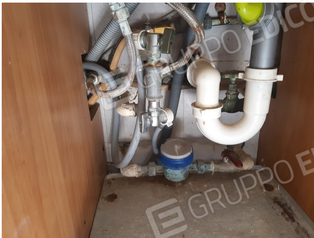
Vista particolare dotazione utenze: contatore impianto idrico
