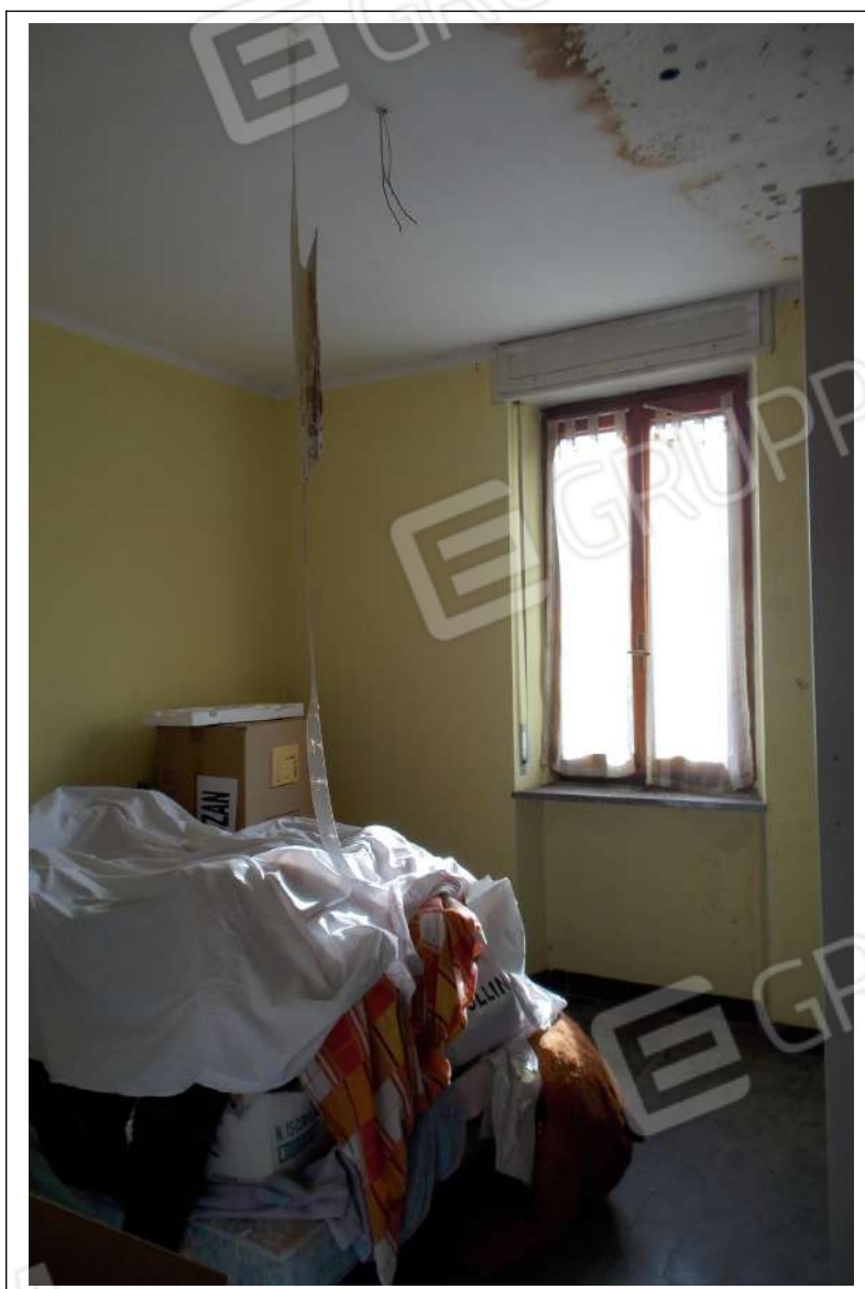
Fotografia n. 10 = LOTTO 1 CORPO A Vista interna della camera
