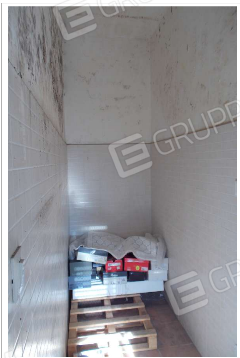
Fotografia n. 9 = LOTTO 1 CORPO A Vista interna del cucininino
