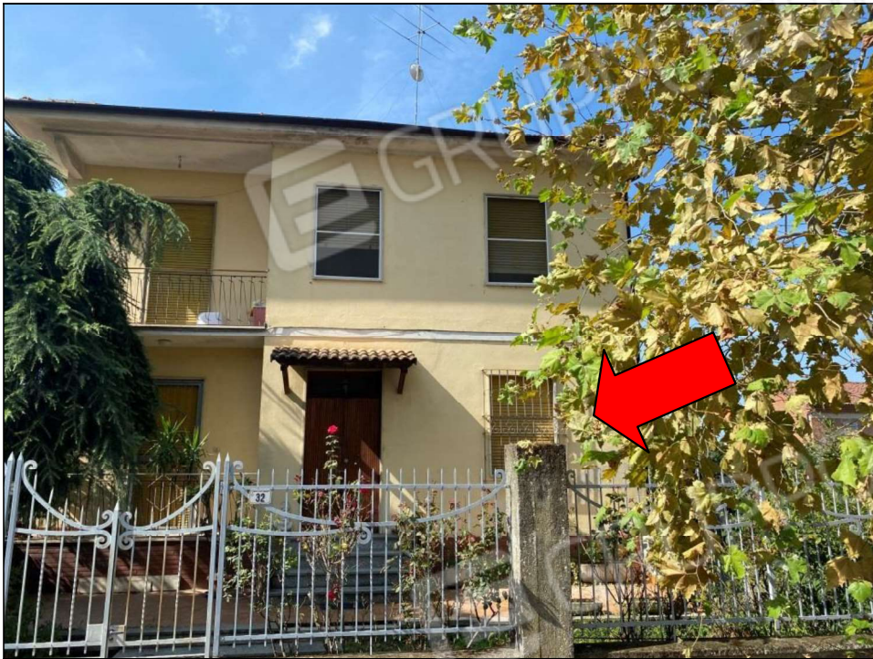
Immagine 5: Prospetto principale su Viale Santa Croce
