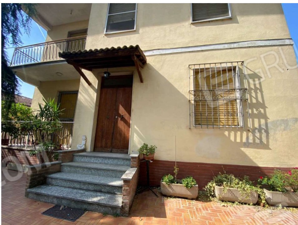
Immagine 8: Ingresso all'alloggio
