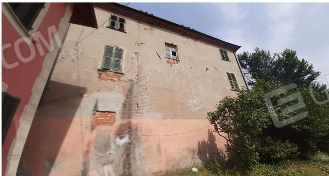
Retro del fabbricato
