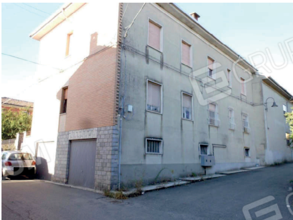
Foto 4 Prospetto retrostante fabbricato mapp.851
