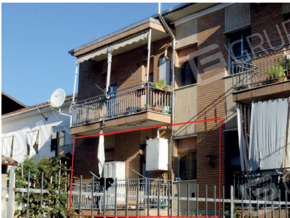
Foto 2 Prospetto alloggio mapp.851 sub.1
