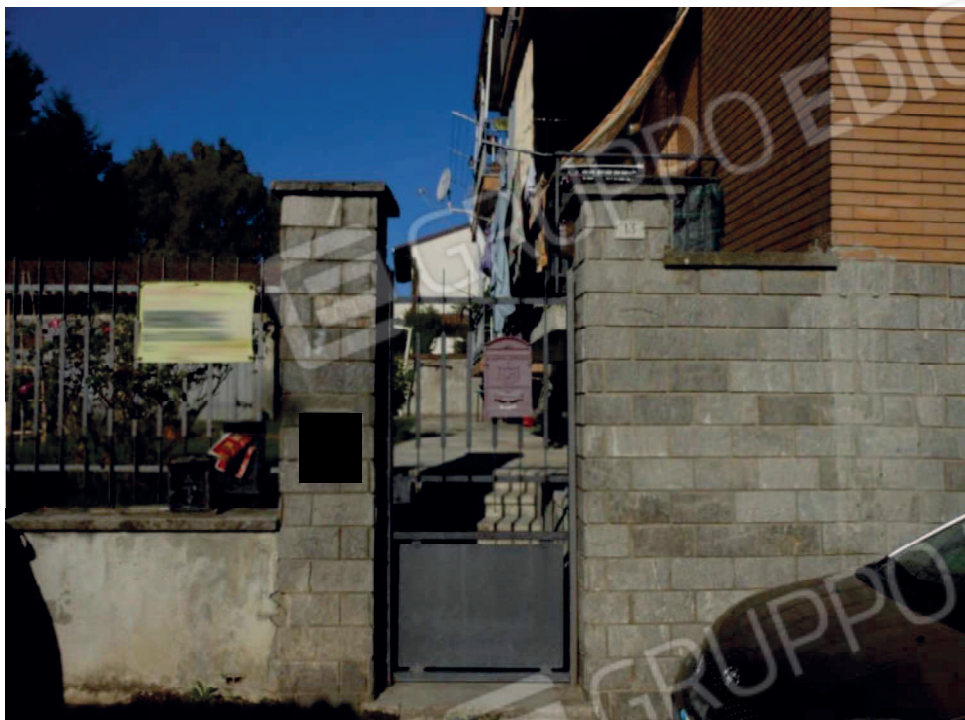
Foto 3 ingresso pedonale su Via Motta
