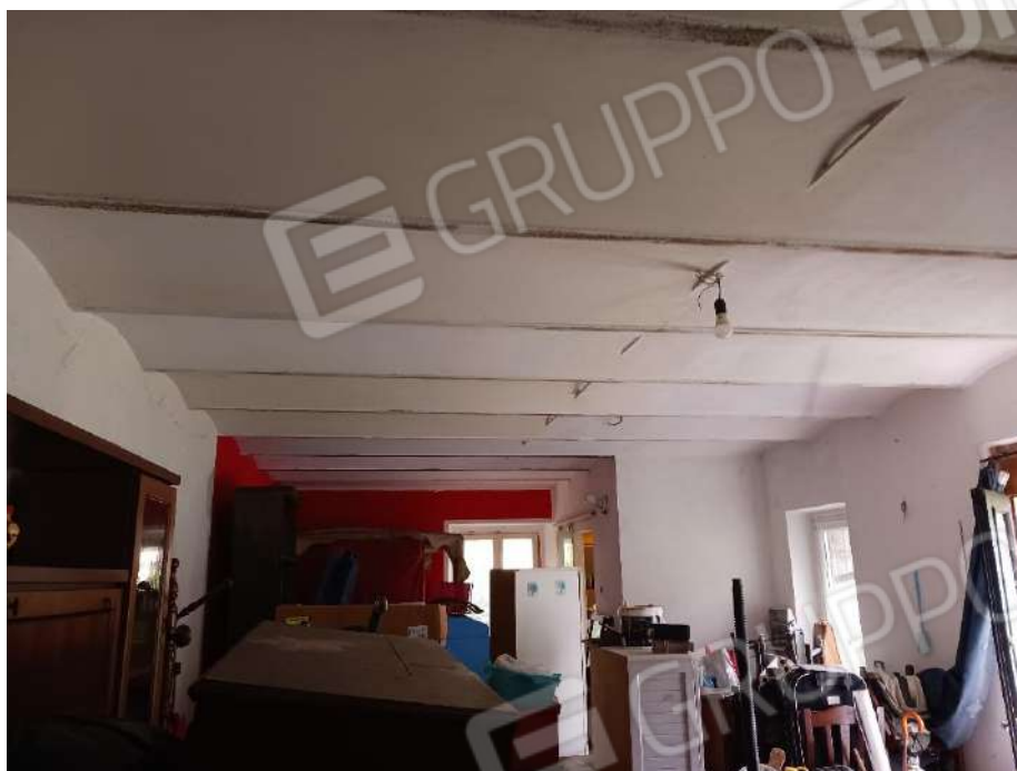
VISTA INTERNA DEL PIANO TERRENO LOCALE DEPOSITO
