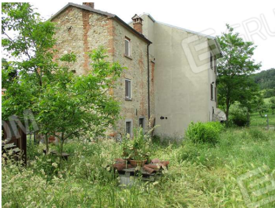
VISTA DAL TERRENO DI PERTINENZA (POZZO)
