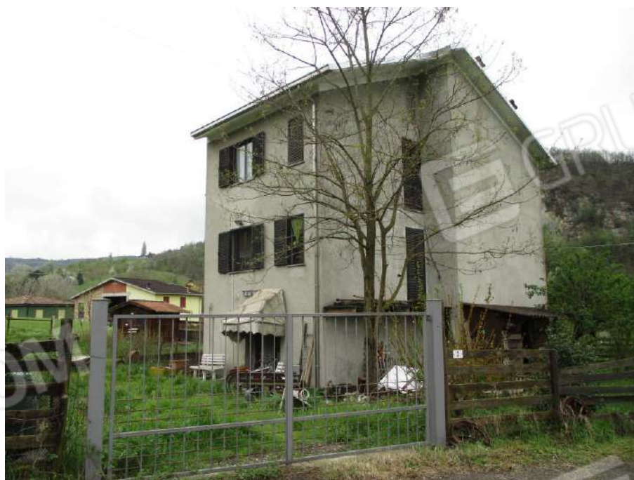
VISTA DELL'ACCESSO CARRAIO
