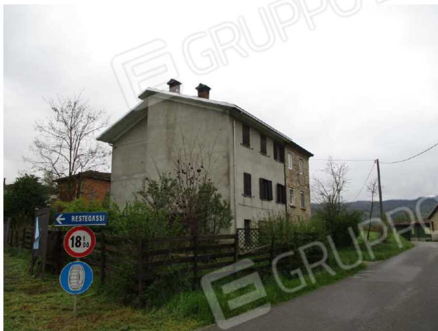
VISTA GENERALE DALLA STRADA SAN SEBASTIANO -DERNICE
