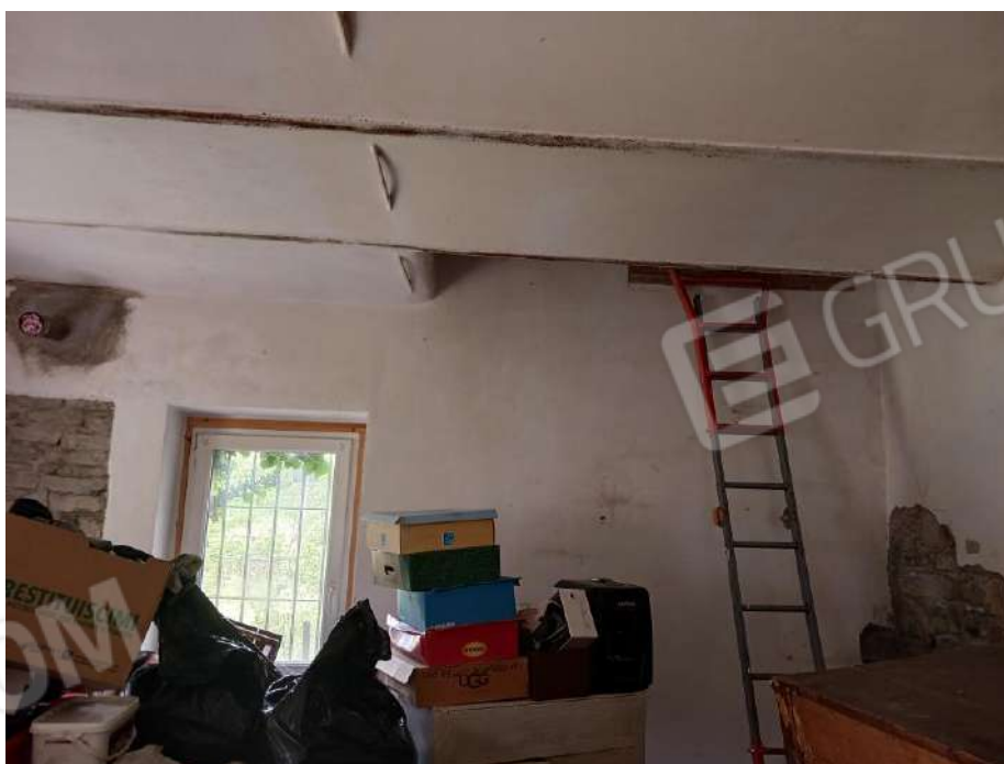
FORO DI ACCESSO AL PIANO PRIMO
