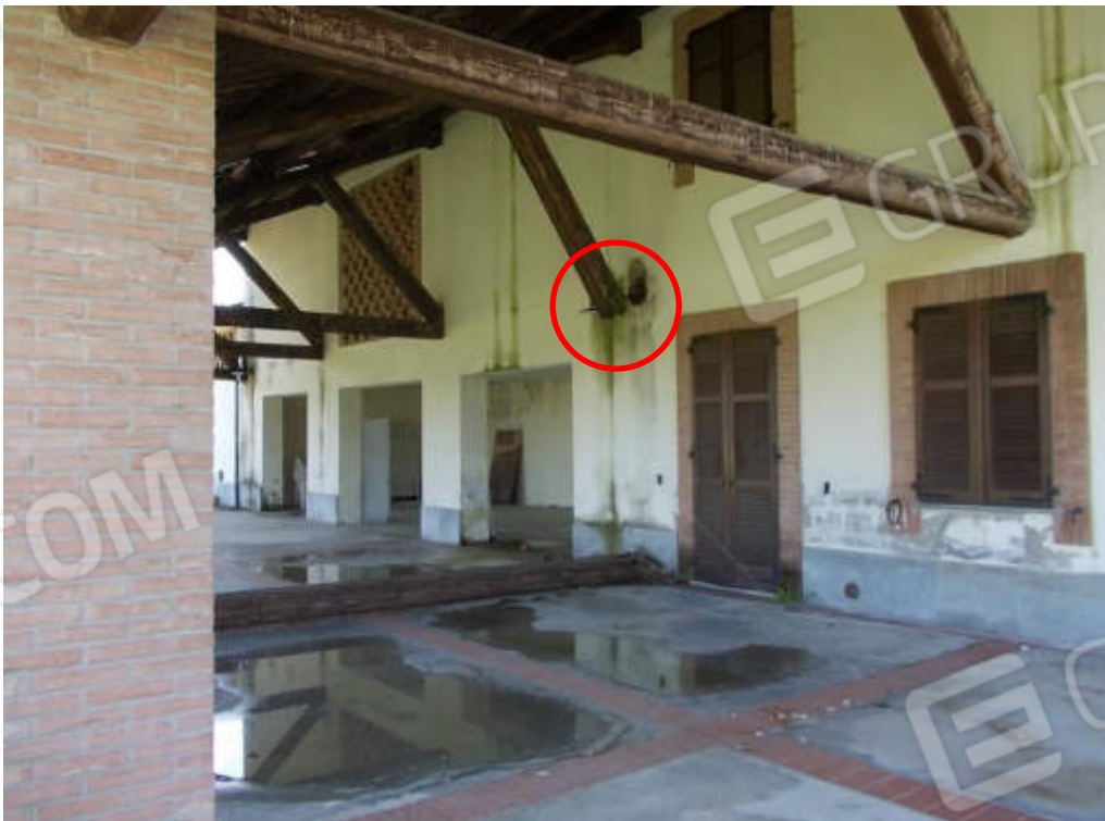
Foto 8 Trave spezzata capriata tettoia corpo A
