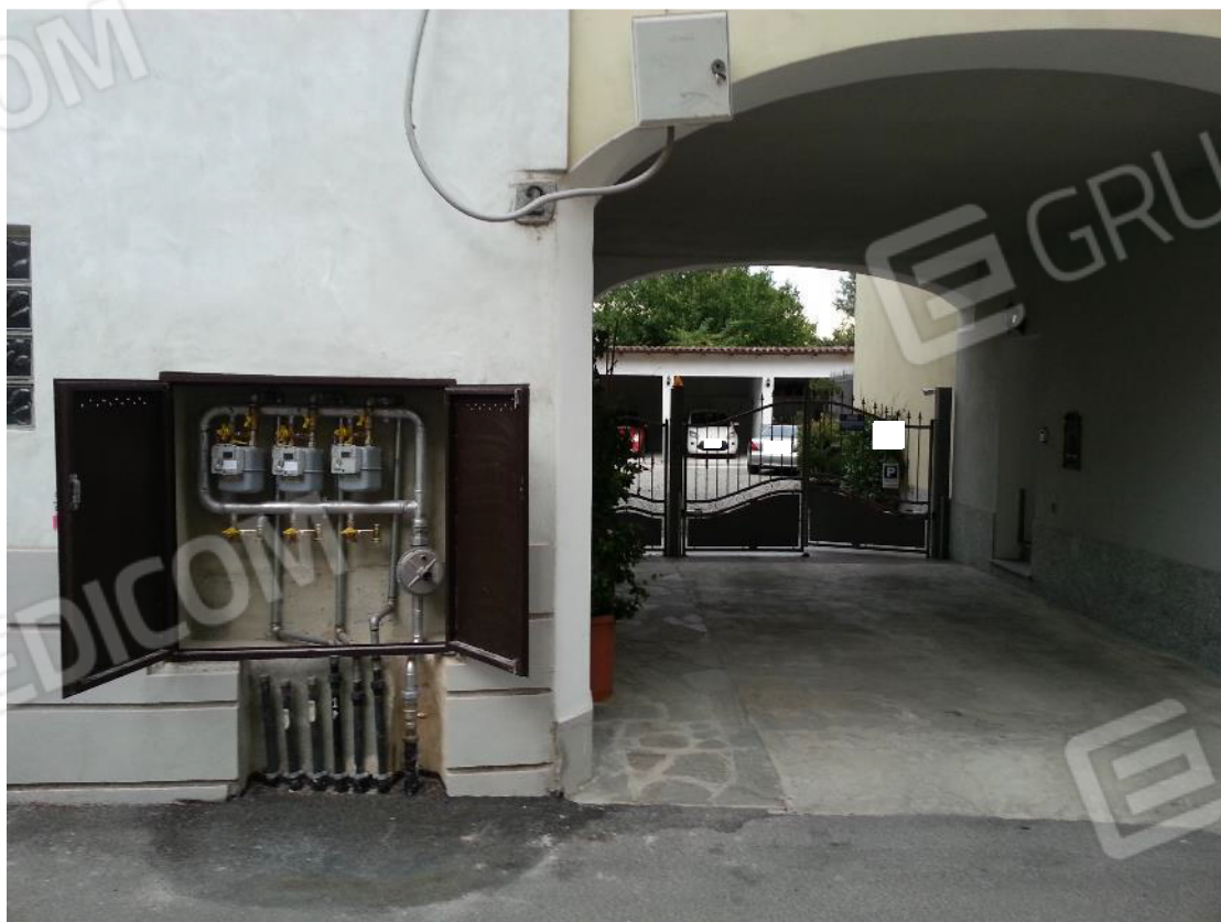
Foto 04 – Via Parsi 2 - Ingresso carraio al cortile interno
