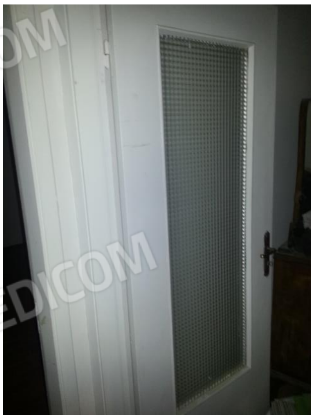
Foto 14 – Dettaglio porta interna subalterno 12
