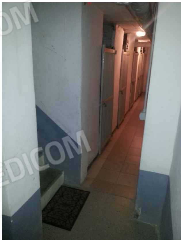
Foto 27 – Vista su corridoio cantine
