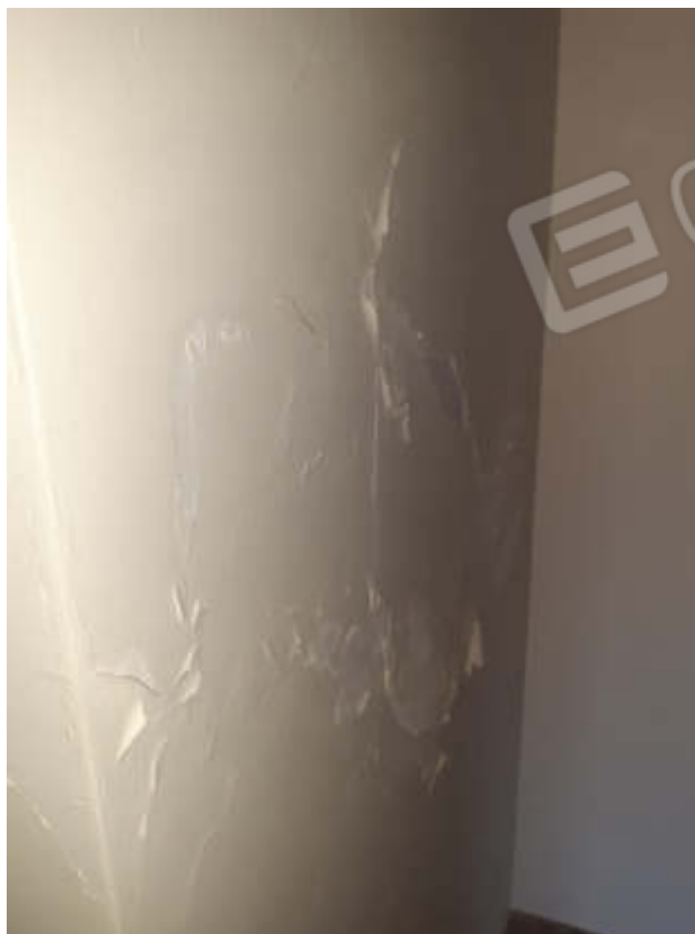
Vista particolare degli ammaloramenti accertati sulle superfici interne della U.I.U.
