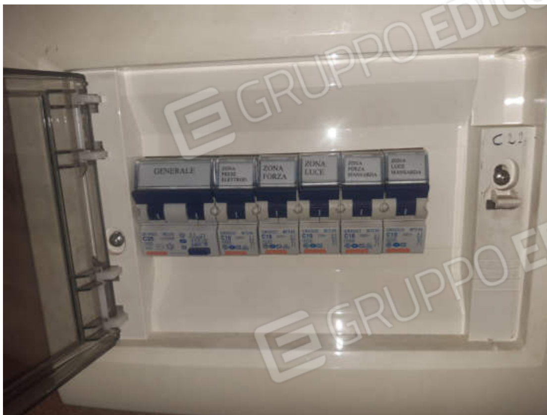
Vista particolare quadretto di utenza impianto elettrico
