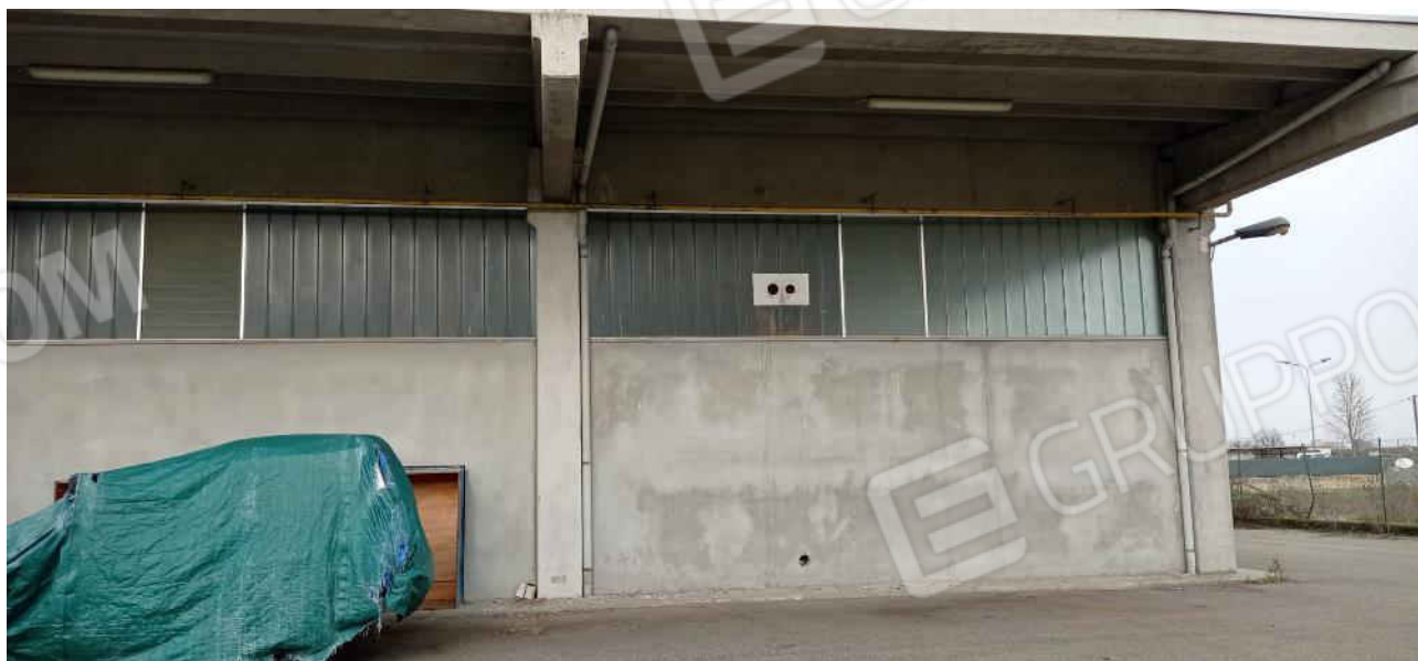
21-Vista esterna lato sud ovest
