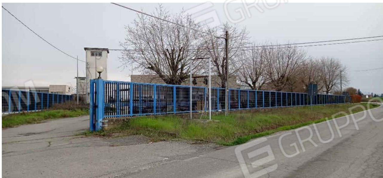
43-Vista nord ingresso verso esterno
