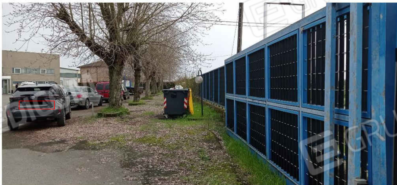
45-Vista nord ingresso verso recinzione interna
