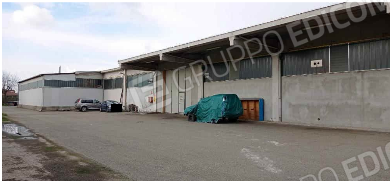
11- Vista esterna capannone lato sud ovest interno
