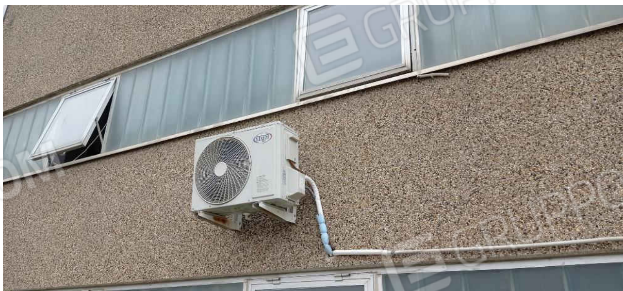
38-Vista esterna lato nord
