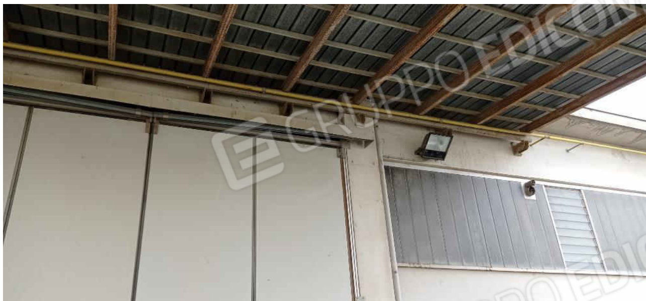
33-Vista esterna lato est
