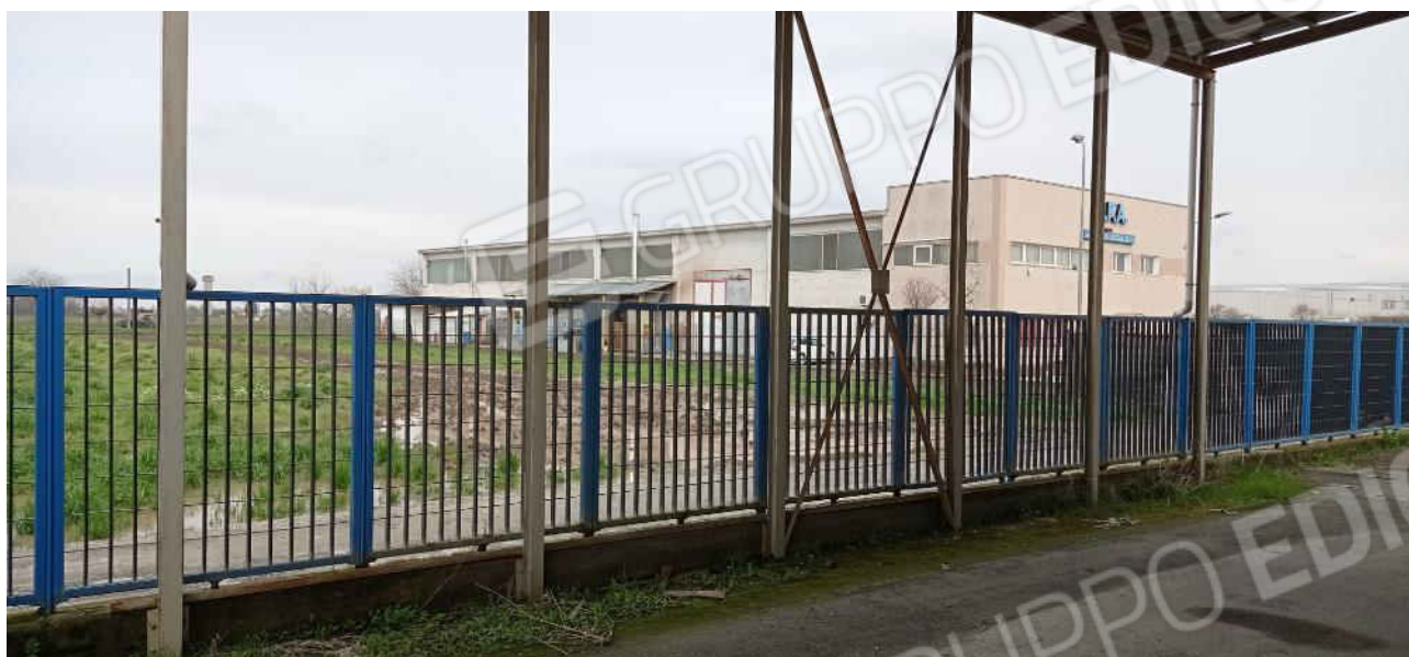
31-Vista esterna lato est
