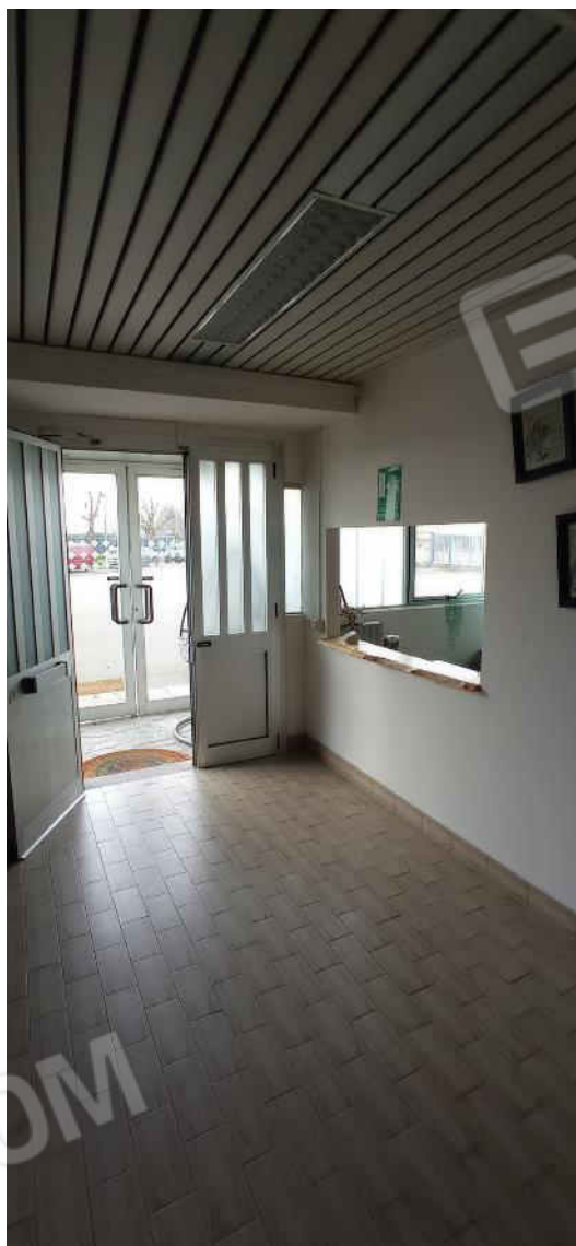
46-ingresso zona uffici piano terreno
