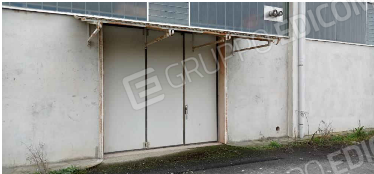
17- Vista esterna pensilina capannone lato est
