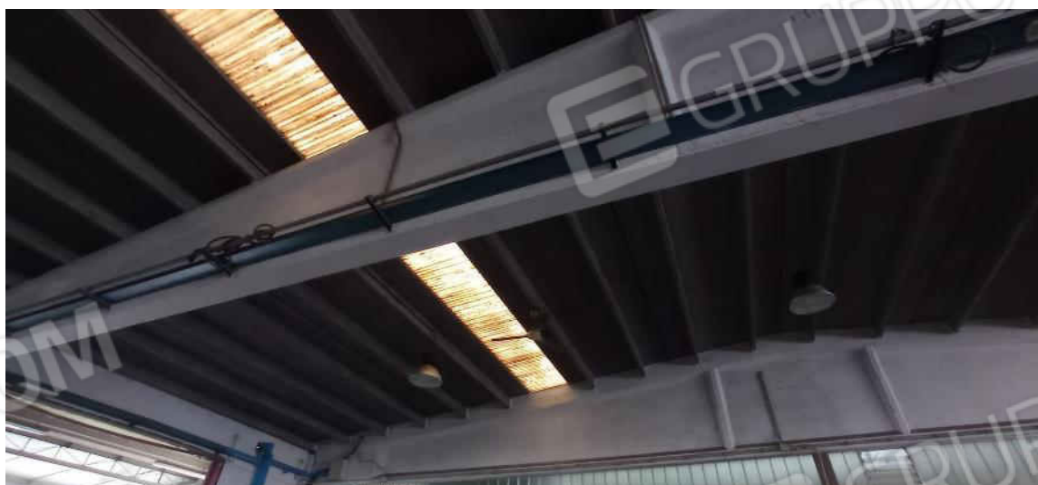
90-interno capannone, dettaglio copertura
