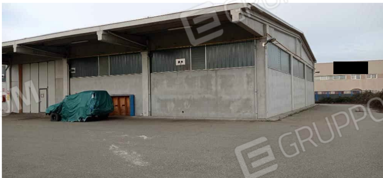
12- Vista esterna interno lato sud ovest
