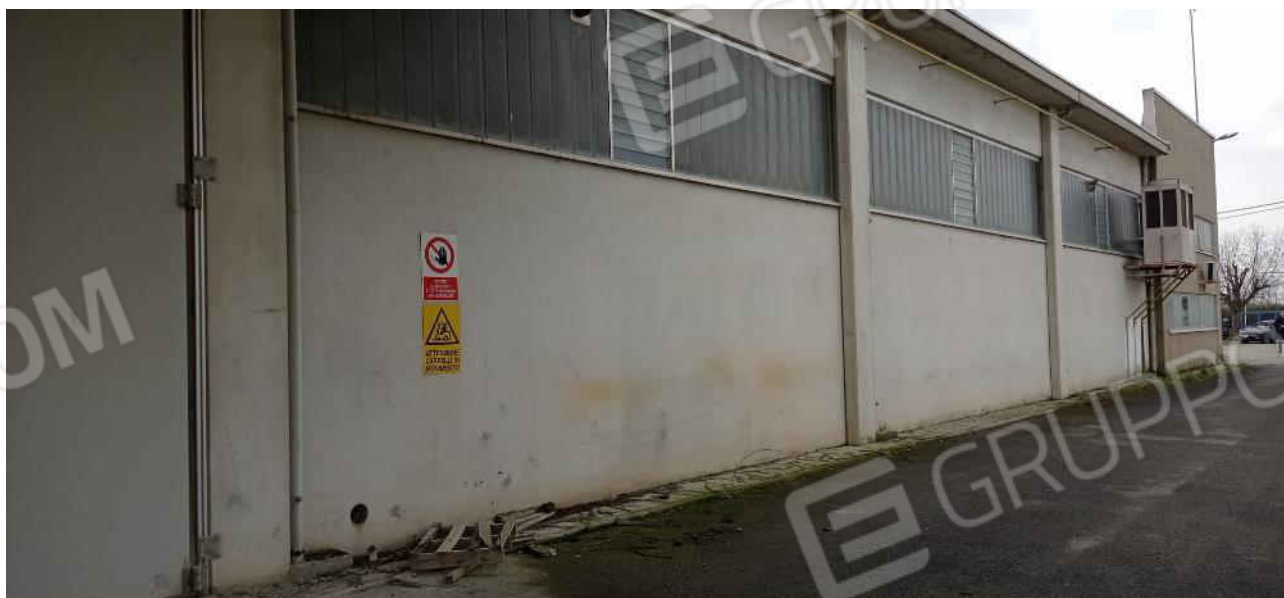
34-Vista esterna lato est
