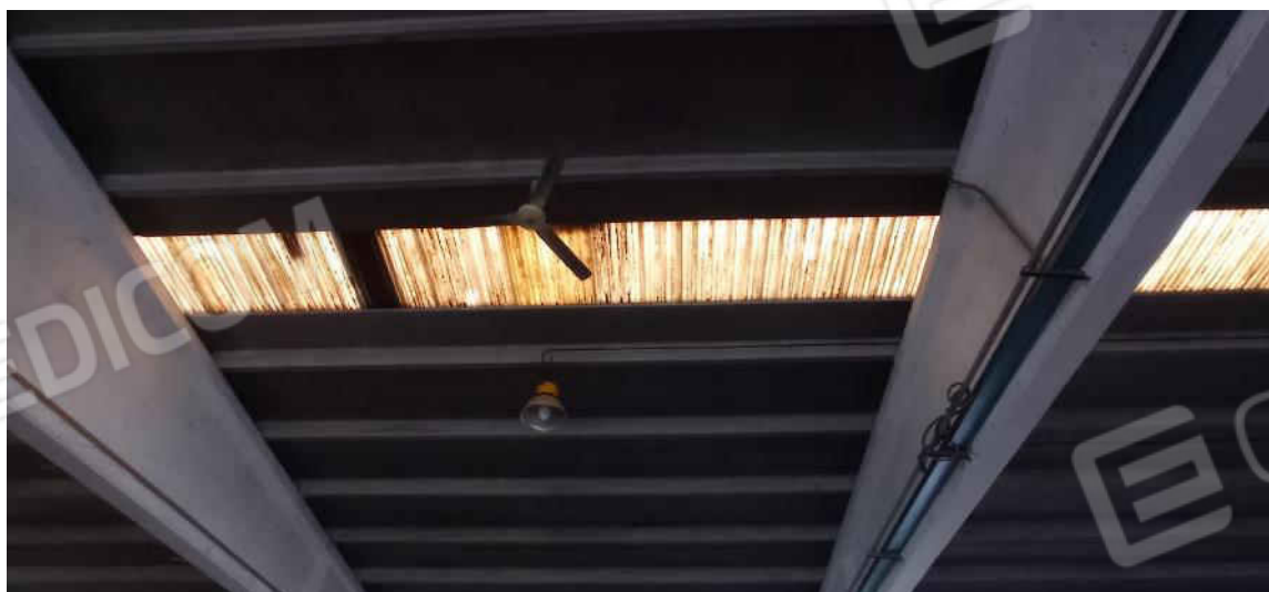
88-interno capannone, dettaglio copertura
