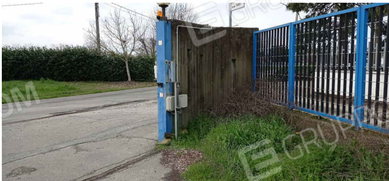
41-Vista nord ingresso verso esterno
