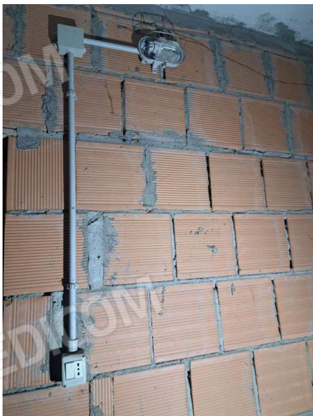
Figura 13- predisposizione impianto elettrico
