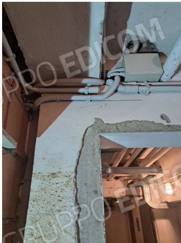
Figura 6- canaline esterne area comune - predisposizione impianto elettrico
